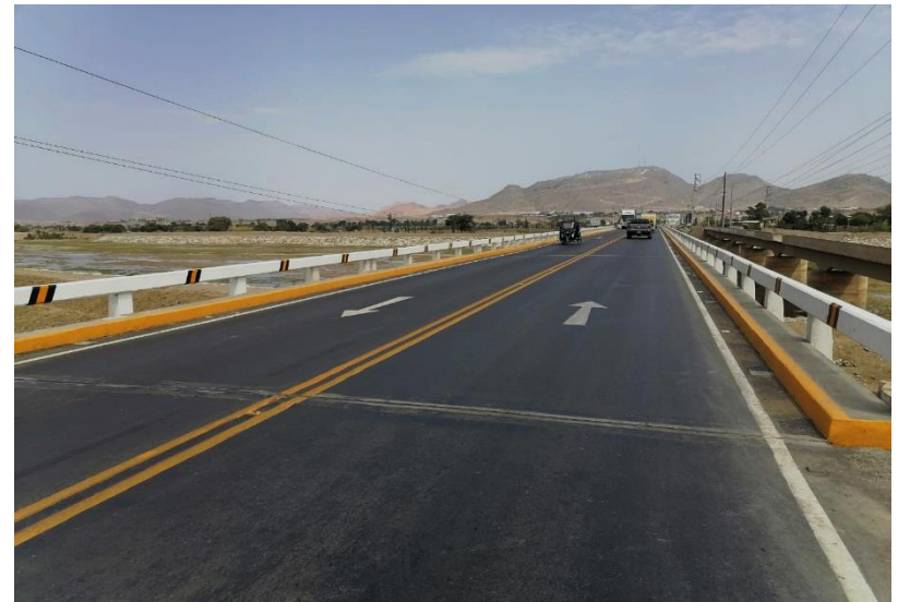
PUENTE LA LIBERTAD (100%)
