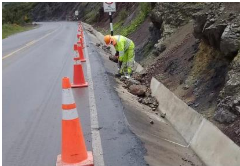
Limpieza de Alcantarilla
