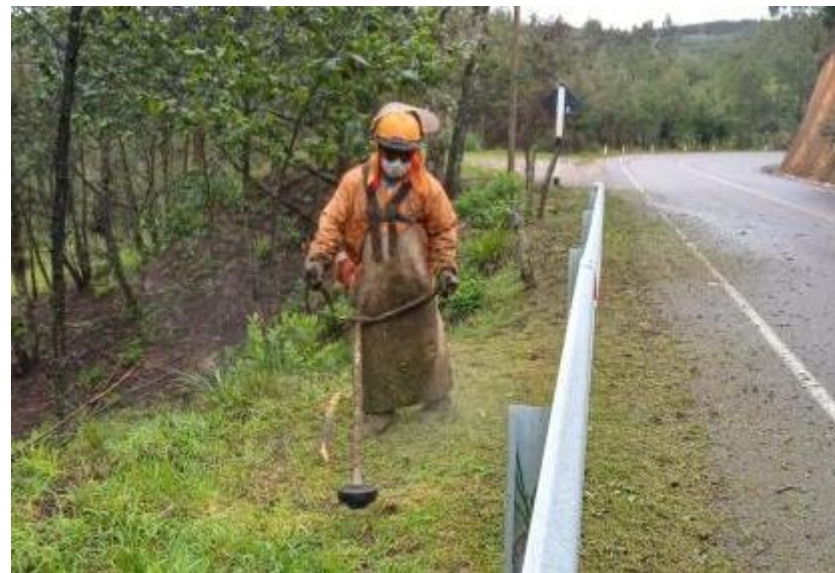
Desbroce de Vegetación
