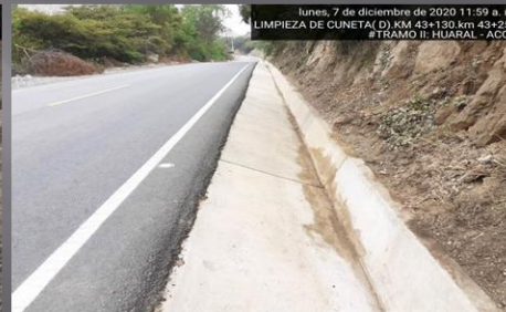
Limpieza de Cunetas
