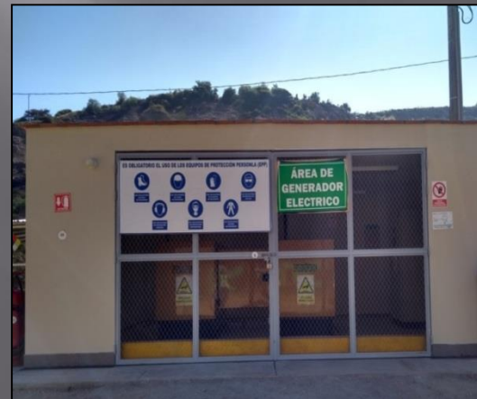
Para la seguridad de los trabajadores, es obligatorio el uso de elementos de protección para ingresar al cuarto de máquinas
