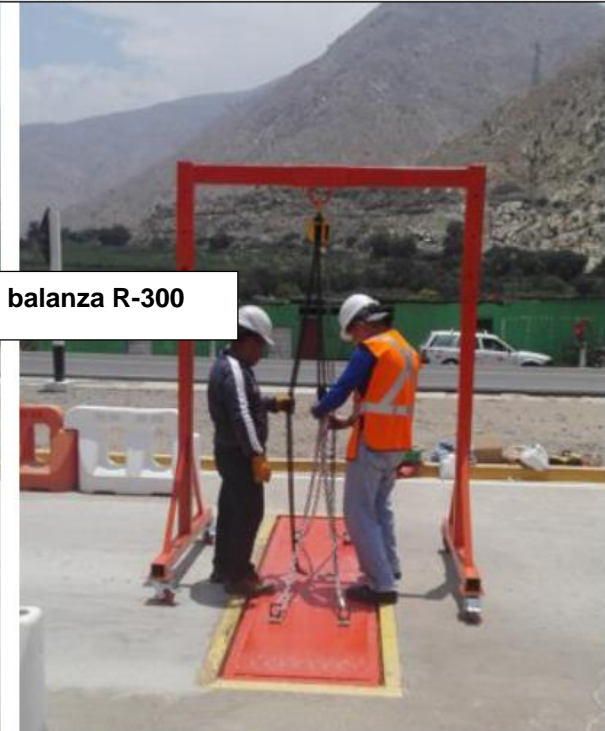
INSTALACION DE TECLE PARA PODER LEVANTAR LA PLATAFORMA DE PESAJE Y PROCEDER CON EL MANTENIMIENTO DEL EQUIPO R300
