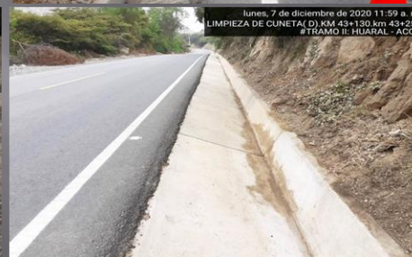
Limpeza de Cunetas
