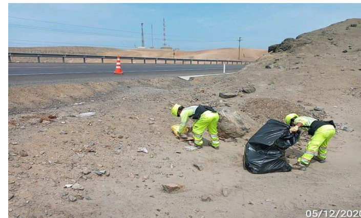
Limpieza de derecho de vía
