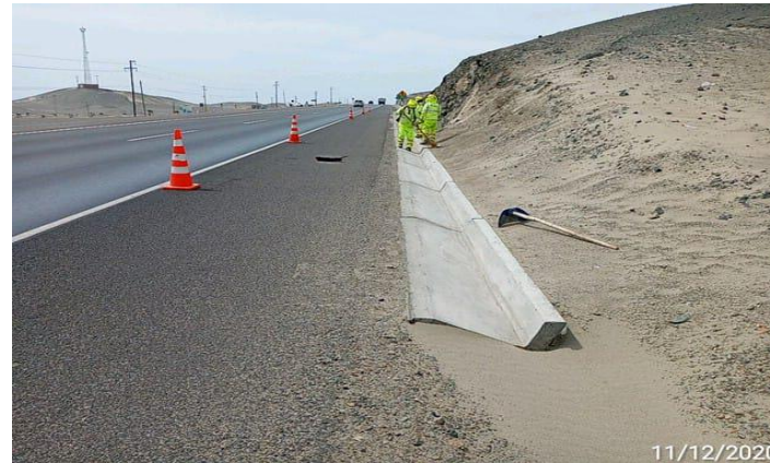
Limpieza de cunetas
