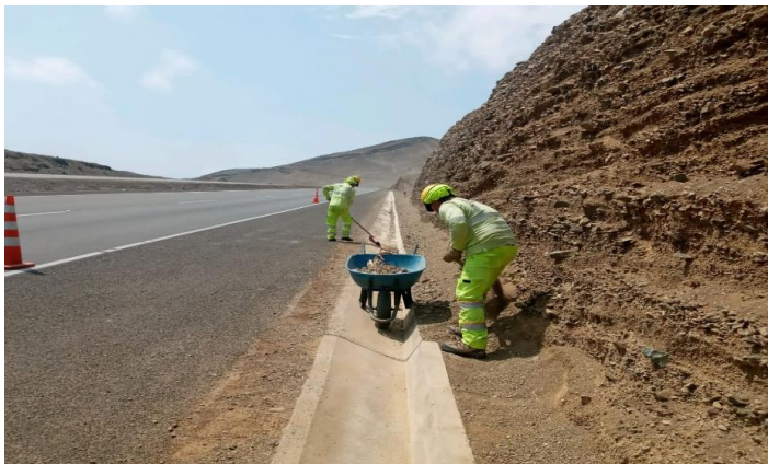
Limpieza de cunetas
