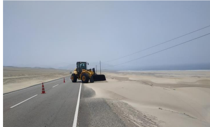
Limpieza de arenamiento
