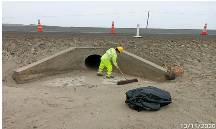
Limpieza de alcantarillas
