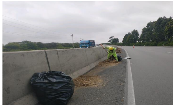
Limpieza de berma
