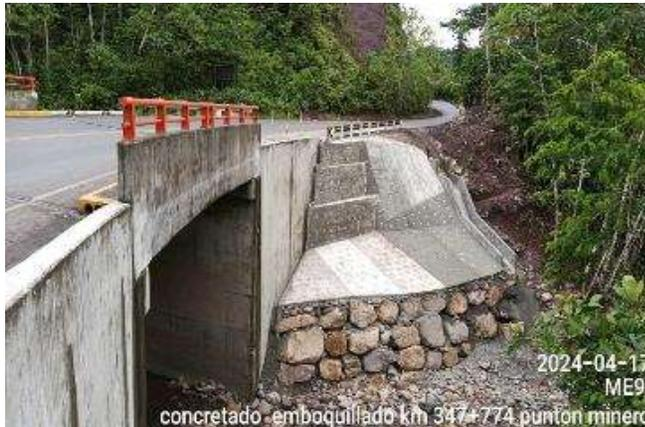
Talud inferior Pontón Minero – Emboquillado y Enrocado
