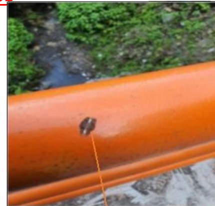
Desprendimiento y cuarteamiento de la Pintura
