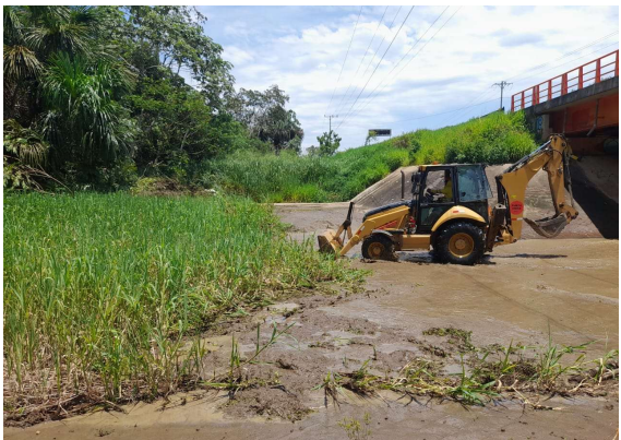
Limpieza de cauce Puentes
