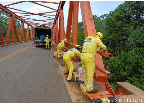
Limpieza de Estructura reticulada
