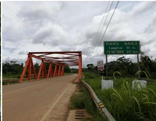
Decoloración de la Pintura del Puente
