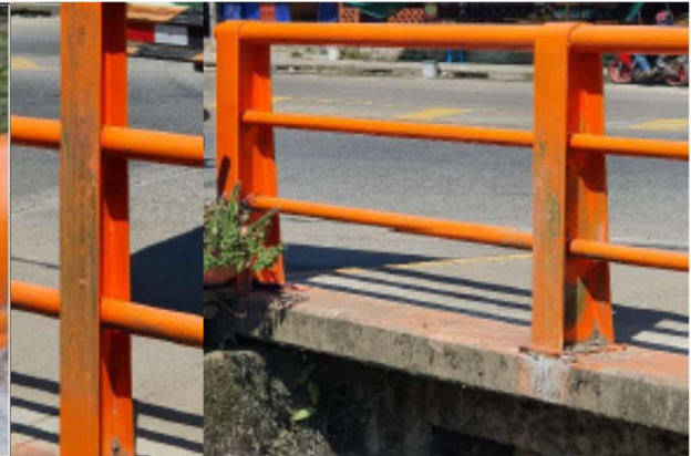
Desprendimiento y cuarteamiento de la Pintura
