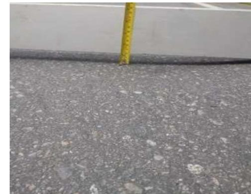
Deterioro en el Pavimento por filtraciones
