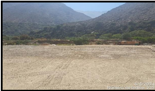
DME – Km. 047+100 SUB TRAMO 1
