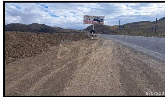
DME – Km. 122+500 SUB TRAMO 3
