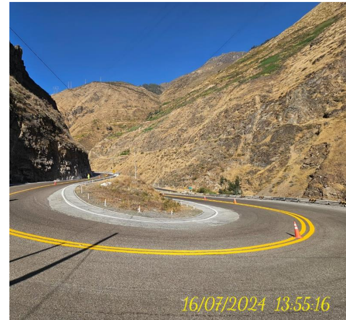
Estado actual de la vía concesionada 2024
