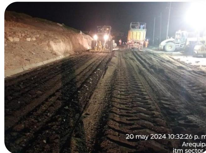
Trabajos nocturnos de reciclado, conformación de la base estabilizada
