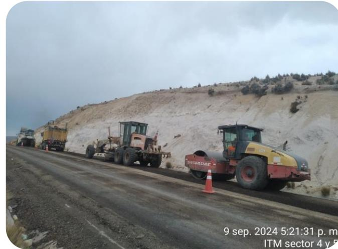
Conformación de base estabilizada y compactación
