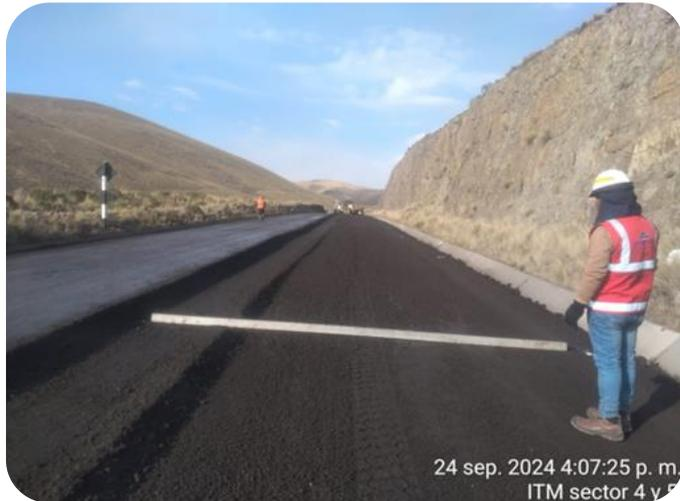
Control de niveles de las secciones transversales
