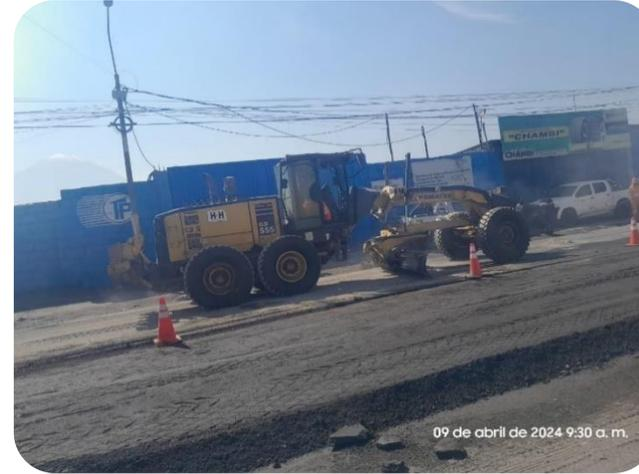
Conformación de la base reciclada con motoniveladora
