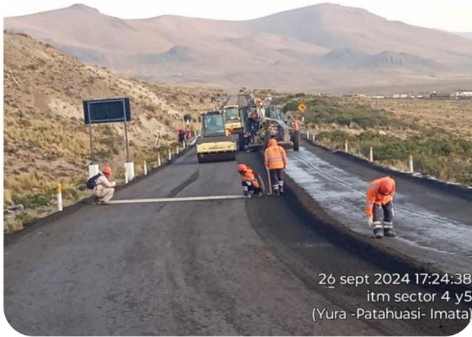
Control de niveles de las secciones transversales
