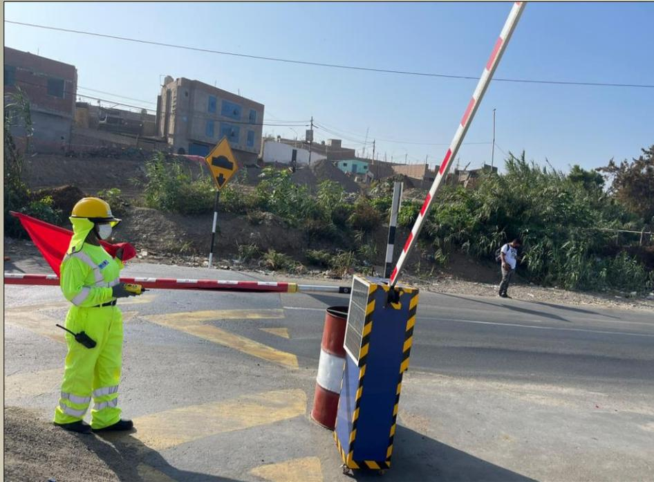
El Sistema S.A.V.I. surge de la necesidad de alejar a nuestros vigías del punto de un posible atropello durante el control de tránsito, para la ejecución de las actividades, consta de una barrera de aluminio, accionada a control remoto desde 100 m, con un panel solar como fuente de alimentación de energía.
