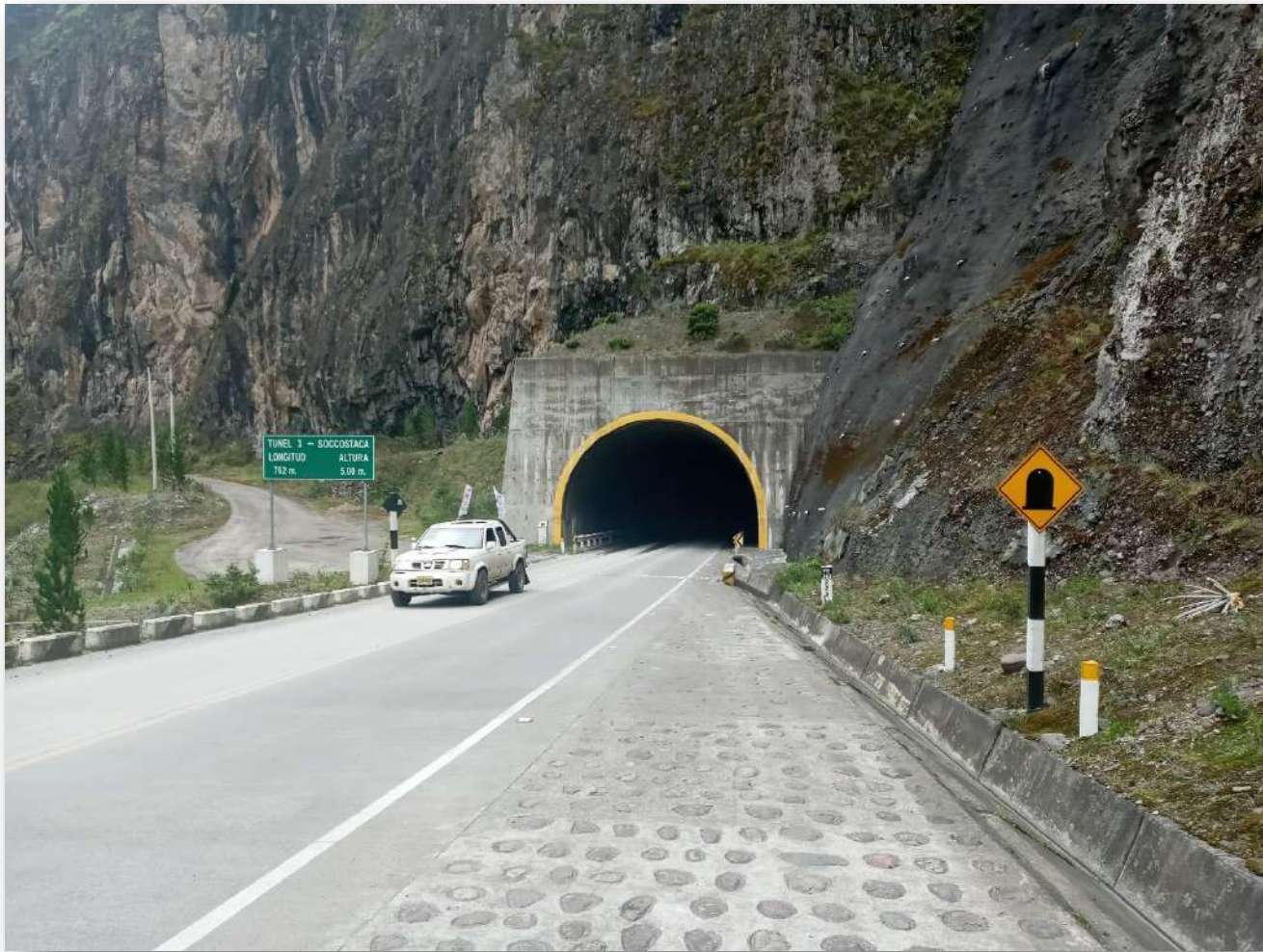
Túnel Soccostaca Km. 222
