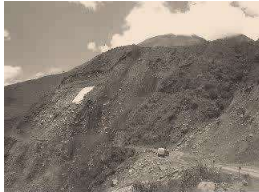
Túnel Wayrasencca (antes)
