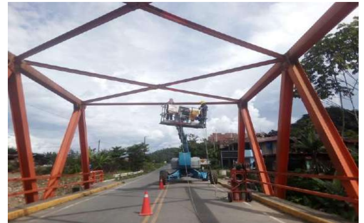
Reparación de elementos estructurales – Puente Lechemayo km 341+707
