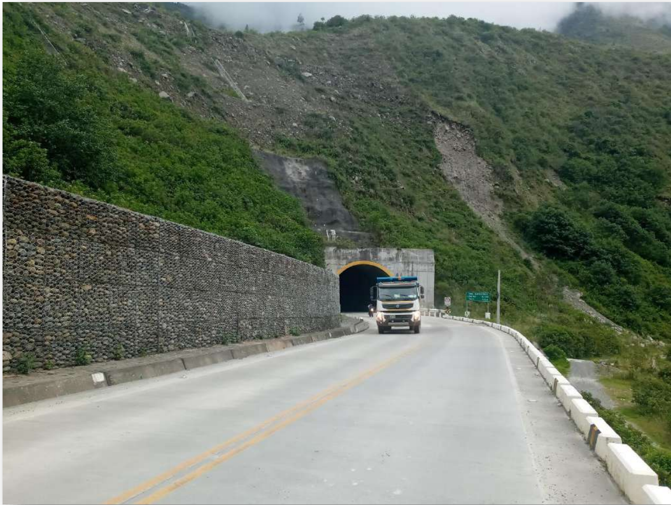
Túnel Wayrasencca Km. 237
