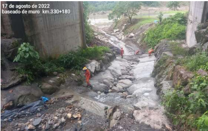
Concretado en Puentes erosionados km 330+180
