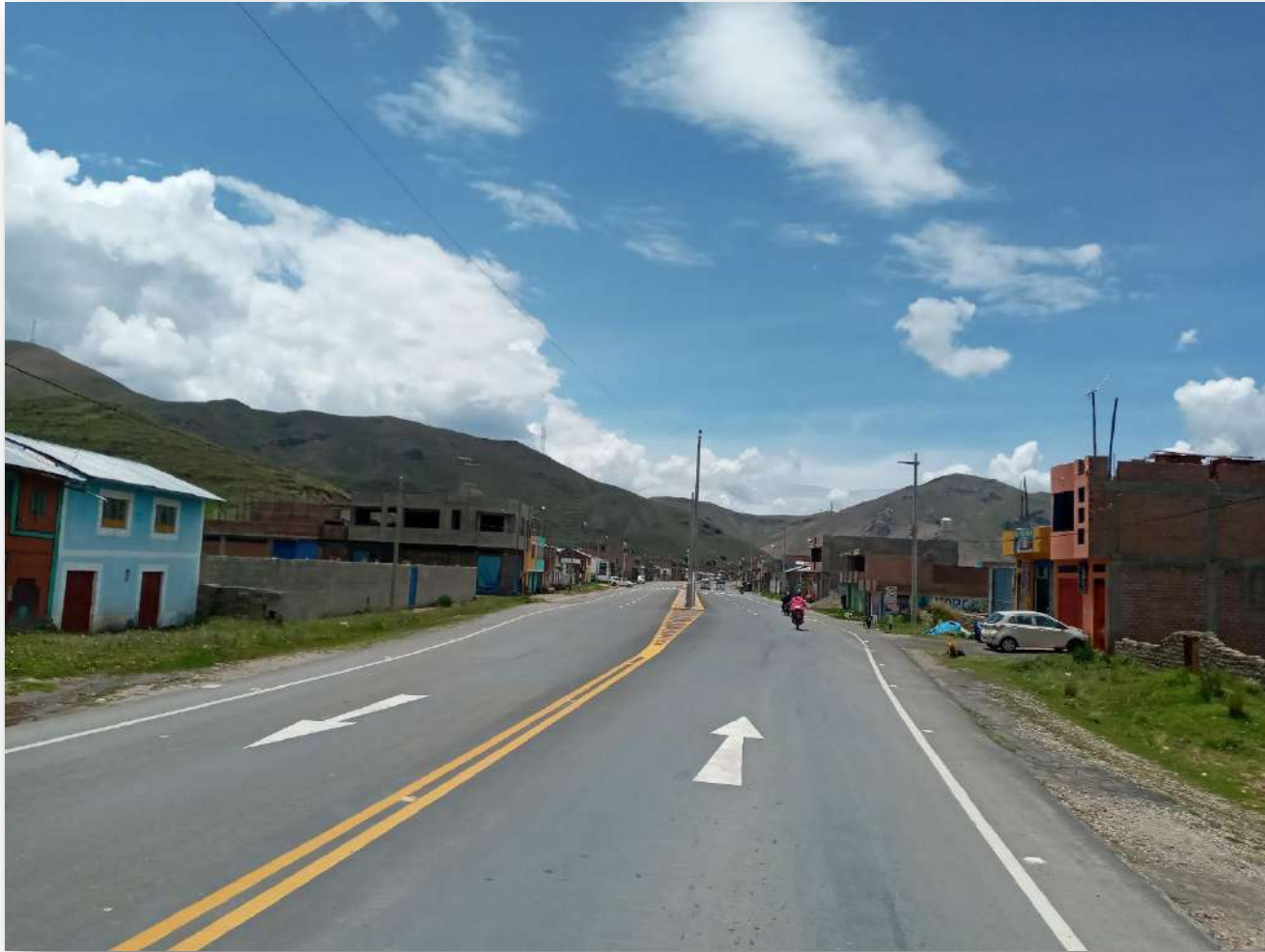
Doble vía San Antón Km. 100
