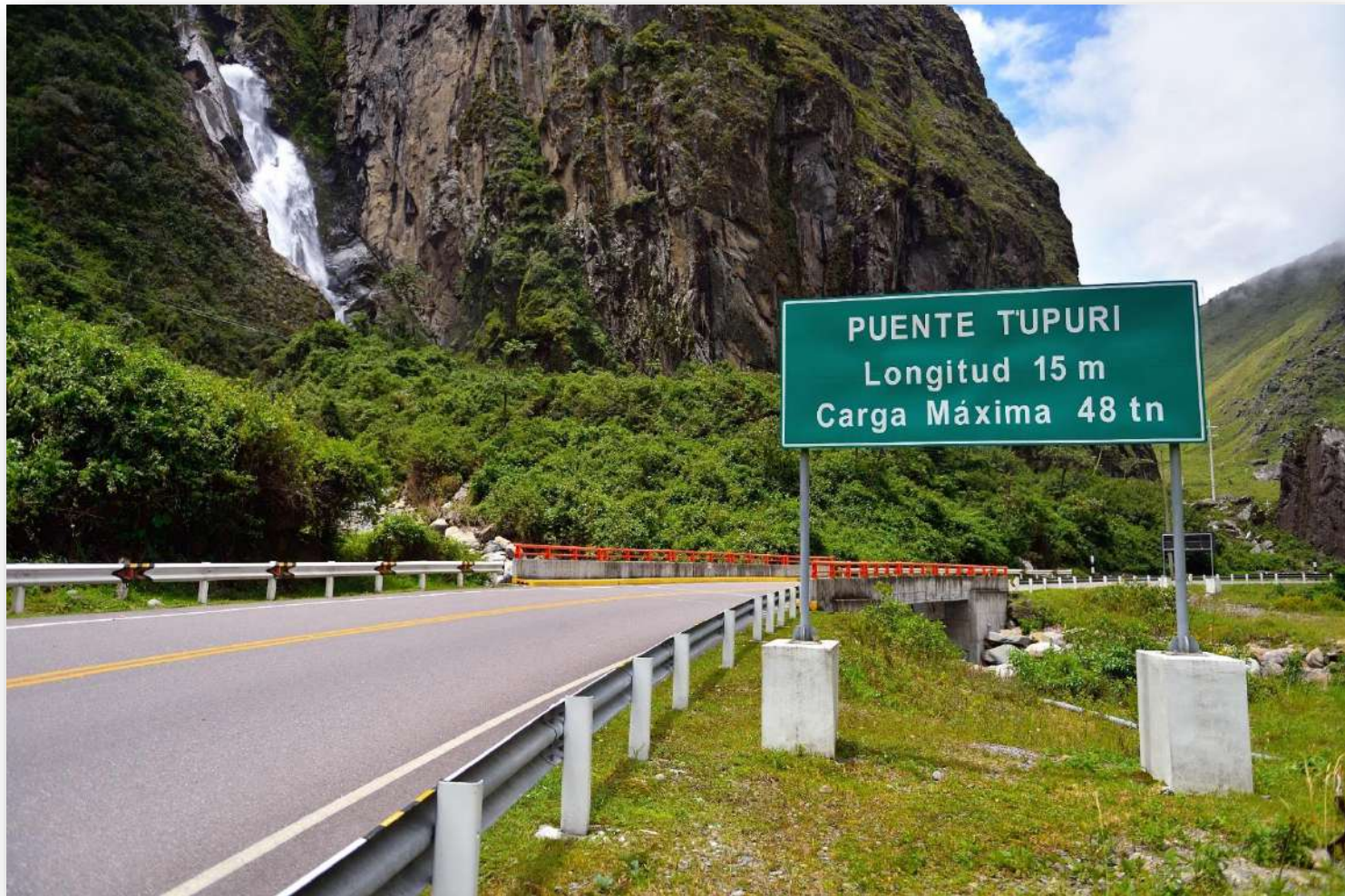
Puente Túpuri Km. 249
