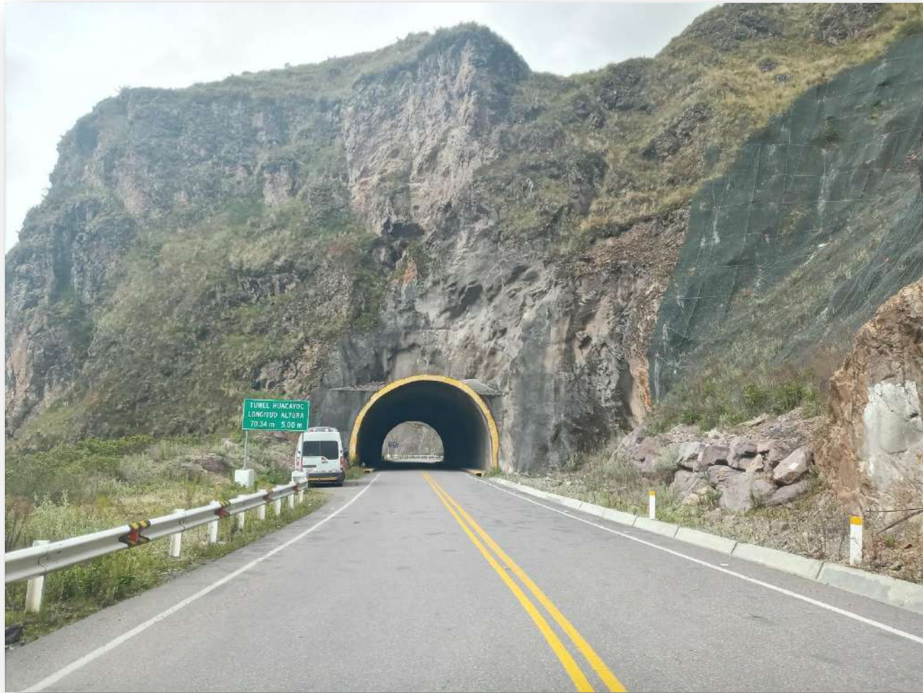
Túnel Huacayoc Km. 213
