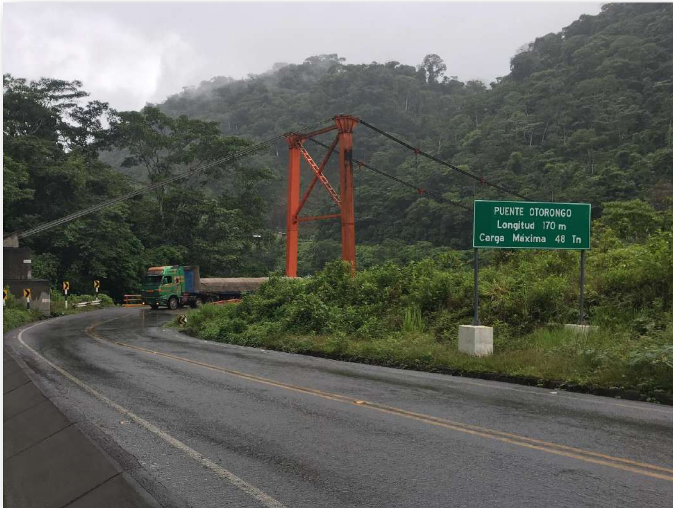
Puente Otorongo Km. 354
