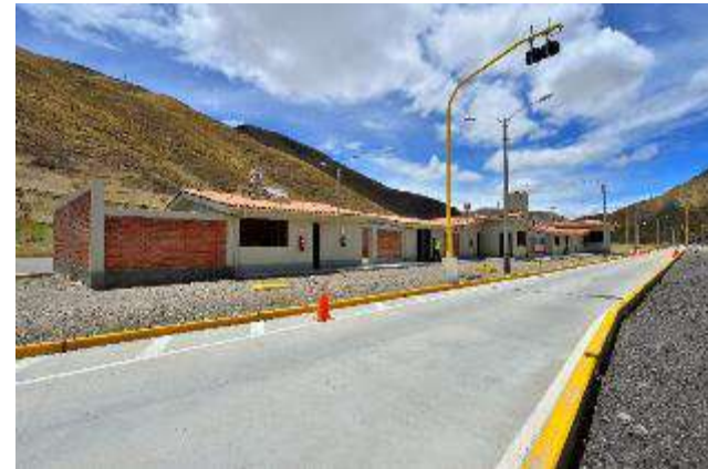
ESTACION DE PESAJE CCATUYO KM 125+500
