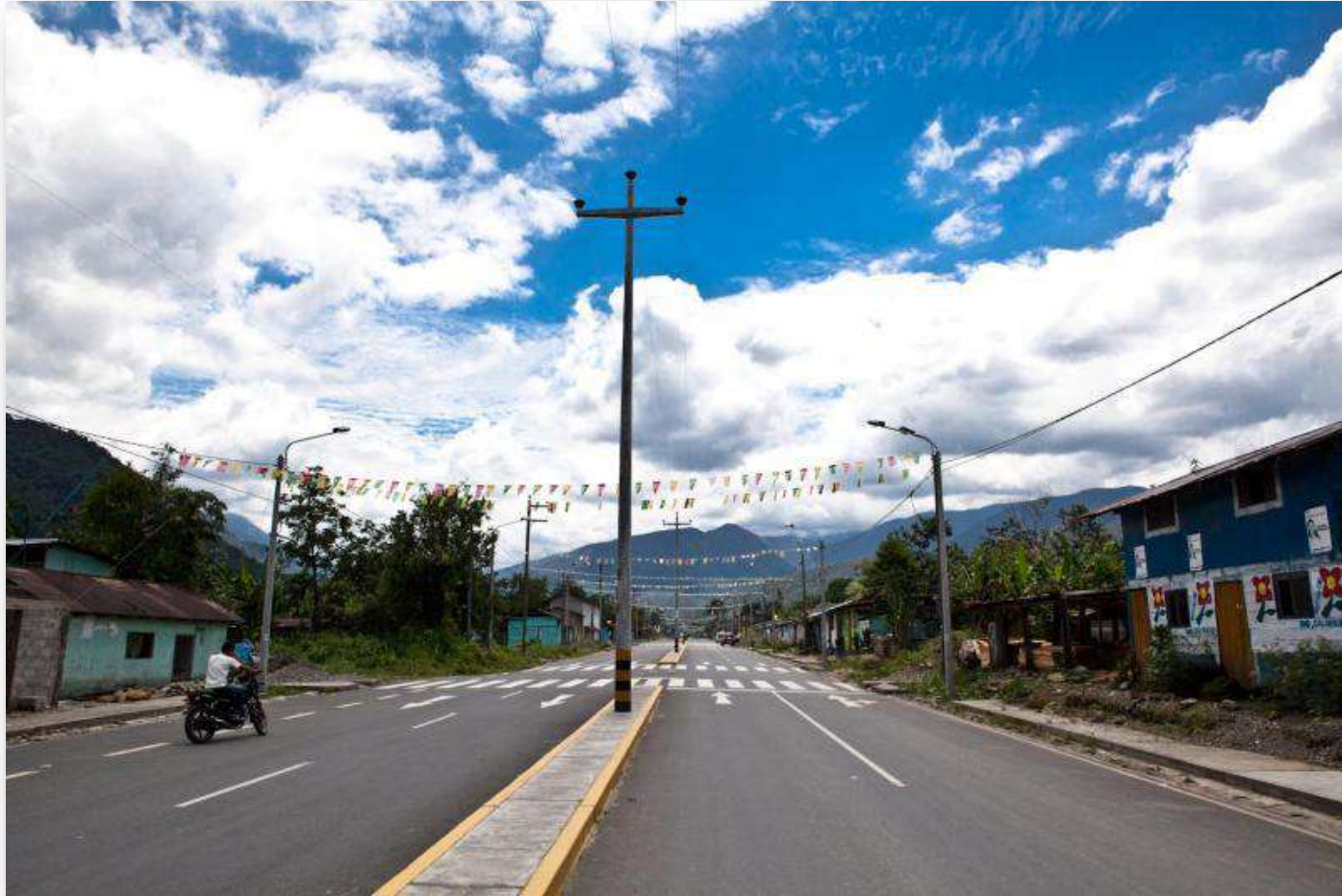
Doble Vía San Gaban Km. 292
