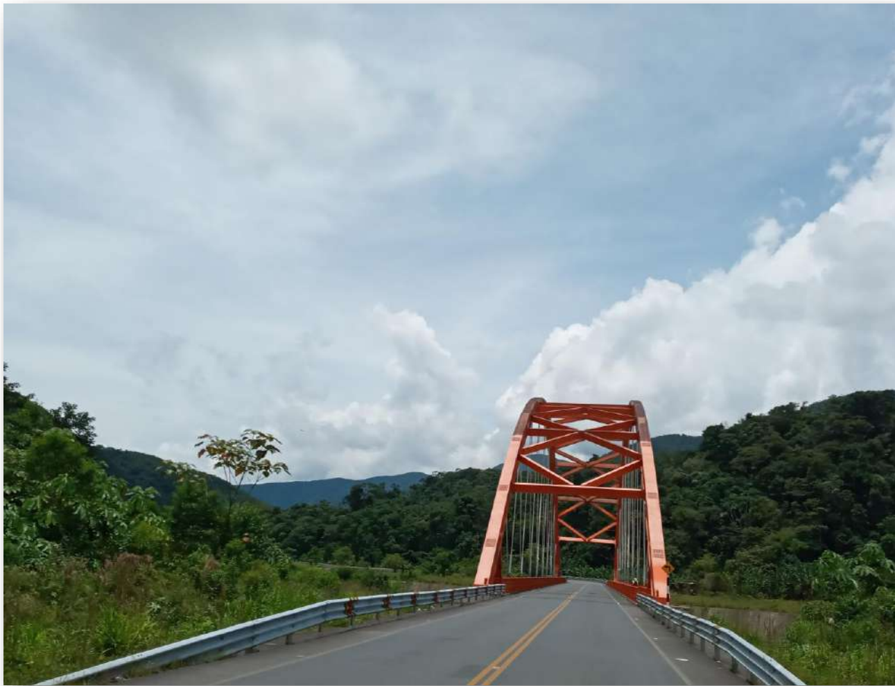
Puente Llocllamayo Km. 295
