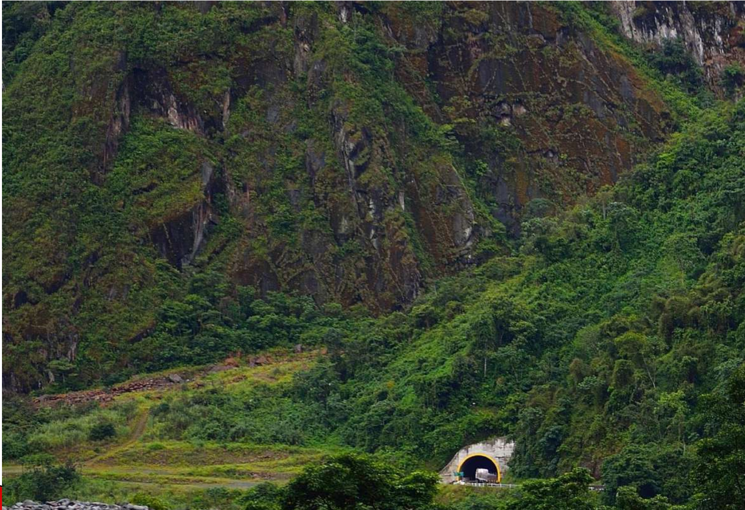
Túnel El Carmen
