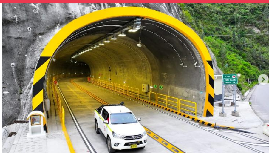
Ilustración N° 1 IIRSA Sur Tramo 4: Túnel Ollachea
