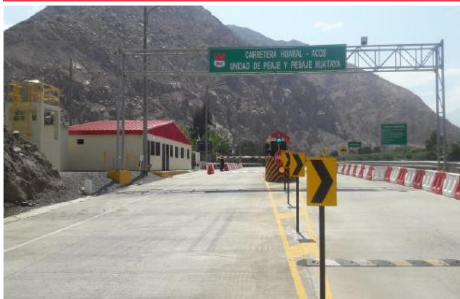
Figura N° 2 Unidad de Peaje y Pesaje Huataya
