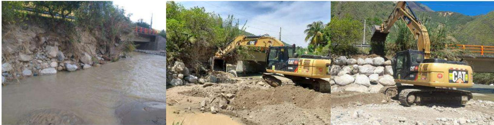
**Tratamiento de Erosión y protección de estribo de Puente Km 151+800**
