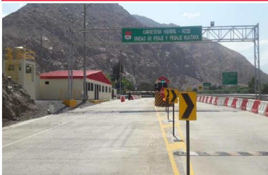
Figura N° 2 Unidad de Peaje y Pesaje Huataya
