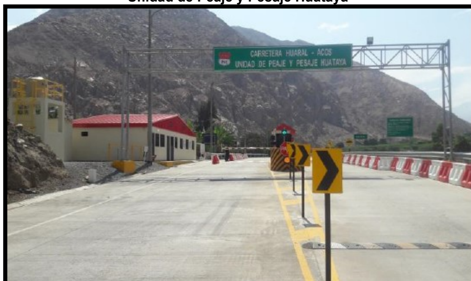
Figura N° 2 Unidad de Peaje y Pesaje Huataya
