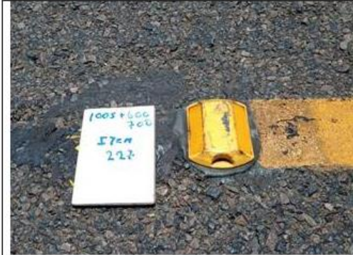
1005+600 - PCI 041-2022 Las láminas de las tachas se encuentran en buen estado, solo se encuentra manchada por la fricción de las llantas de los vehículos al pasar sobre estas.
