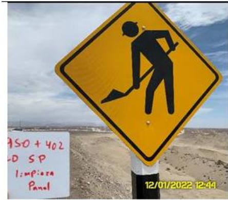
950+402 – PCI 001-2022 No se observa suciedad que impida la lectura del mensaje, siempre va existir un poco de polvo en las señales pues están expuestas al clima de la zona
