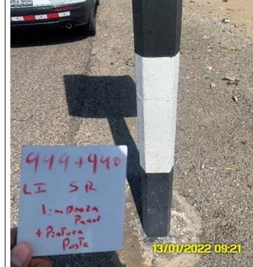
949+940 – PCI 001-2022 No se observa que el poste tenga ausencia o deficiencia en el pintado.
