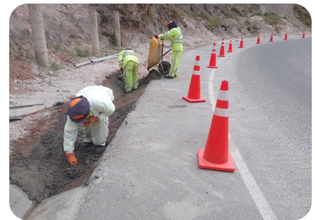
Fotografía 12: Reparación menor de cunetas - Sub tramo 17
