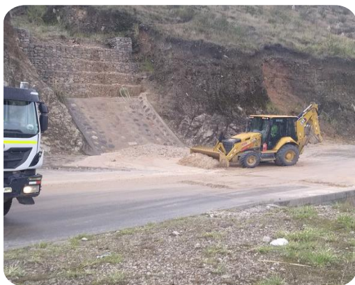
Limpieza de badenes y muros
