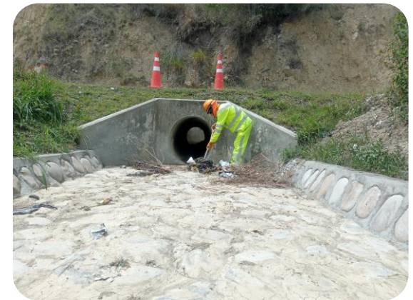
Fotografía 15: Limpieza de Alcantarillas - Sub tramo 04
