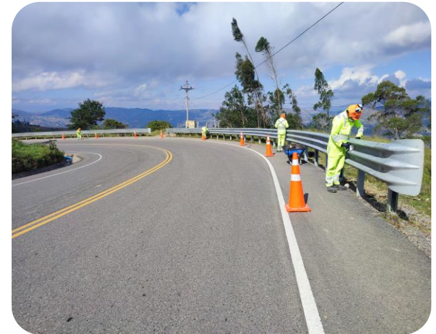
Fotografía 06: Reposición de captafaros - Sub tramo 02
