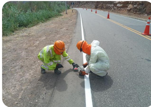
Fotografía 11: Reposición de tachas reflectivas - Sub tramo 17
