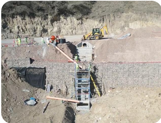
Fotografía 07: Construcción de muro Terramesh – Sub tramo 17
