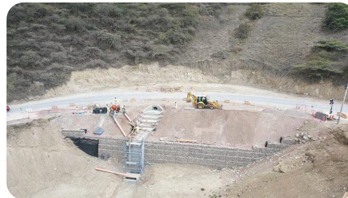
Construcción muro Terramesh
