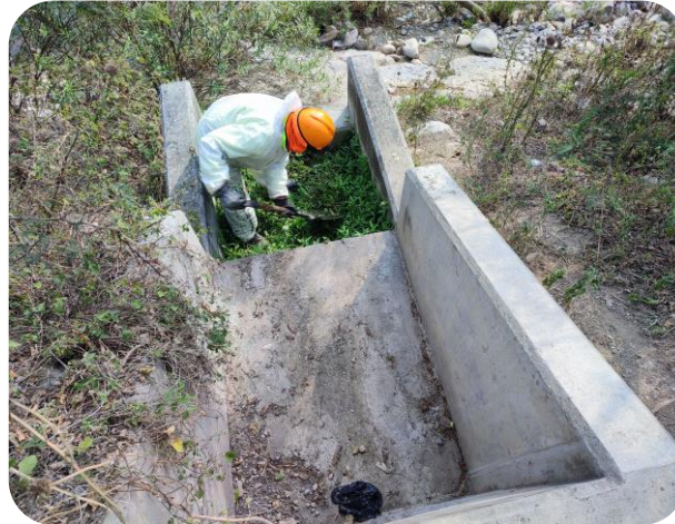
Fotografía 05: Limpieza de alcantarilla - Sub tramo 02
