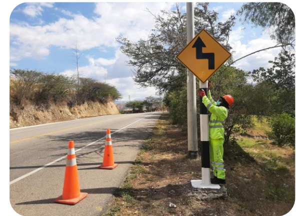
Fotografía 18: Reposición de señales preventivas – Sub tramo 09
