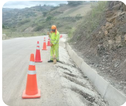
Limpieza de calzada y berma
