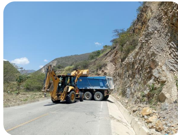
Fotografía 14: Conservación de Derecho de Vía - Sub tramo 03
