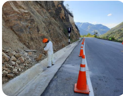
Limpieza de cunetas
