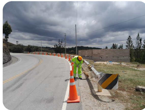
Fotografía 17: Limpieza de guardavías – Sub tramo 05
