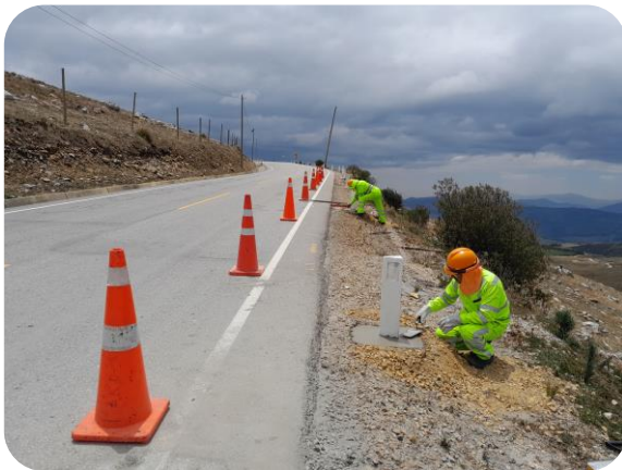
Fotografía 16: Reposición de postes delineadores – Sub tramo 05
