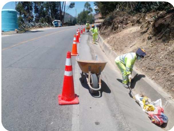
Fotografía 10: Limpieza de cunetas - Sub tramo 17
