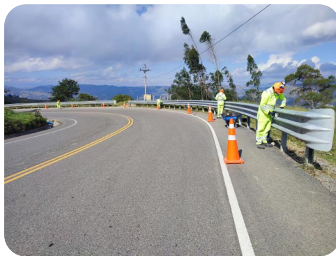
Conservación de guardavías existentes
