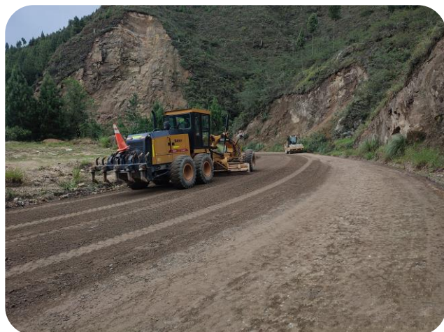
Fotografía 01: Mantenimiento de Tránsito Temporal en sectores no asfaltados - Sub tramo 01
