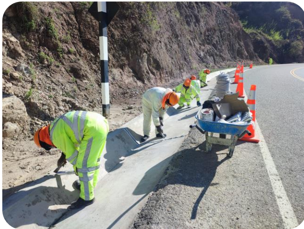
Fotografía 04: Sellado de juntas de cunetas - Sub tramo 02
