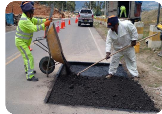
Parchado superficial 1,855.06 m2
