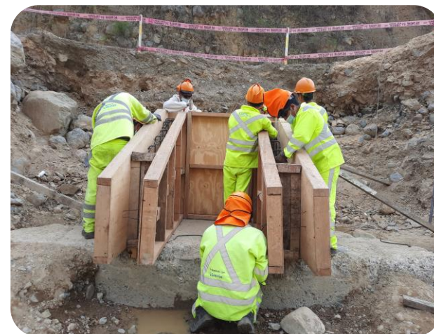
Fotografía 03: Reconstrucción de alcantarillas - Sub tramo 01
