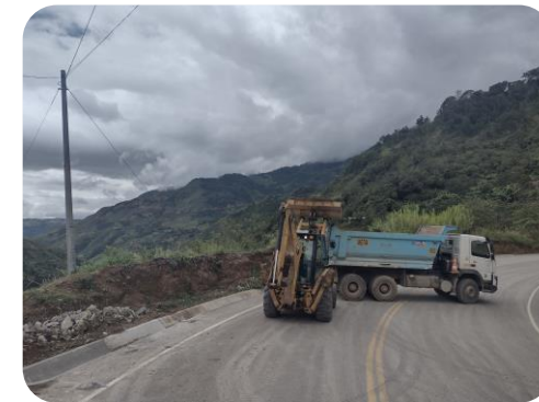
Limpieza de taludes laterales, derrumbes menores y huaycos
