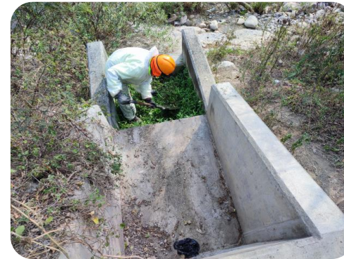
Limpieza y mantenimiento de alcantarillas
