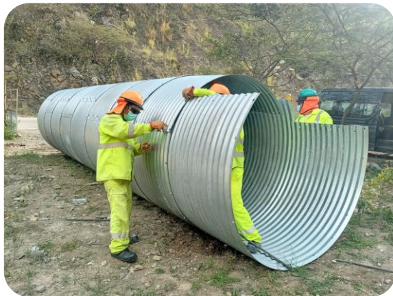
Fotografía 13: Armado de TMC- Sub tramo 03
