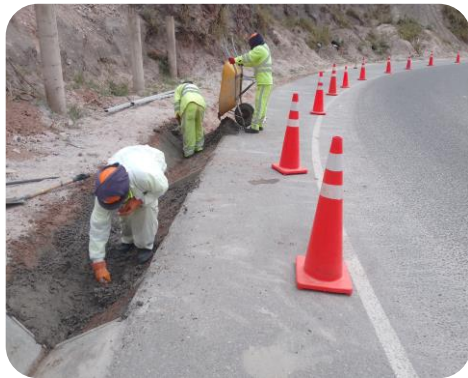
Reparación de cunetas 9,432.51 m
