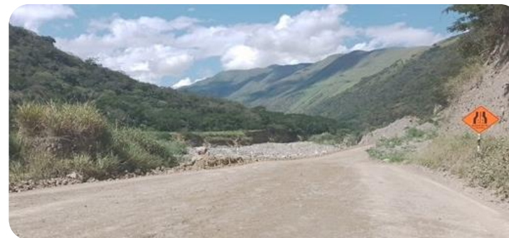
Enrocado y restitución de plataforma
