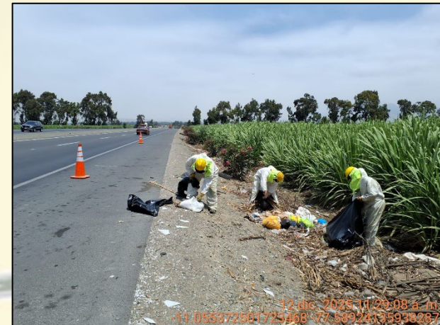
Limpieza de Derecho de Vía
