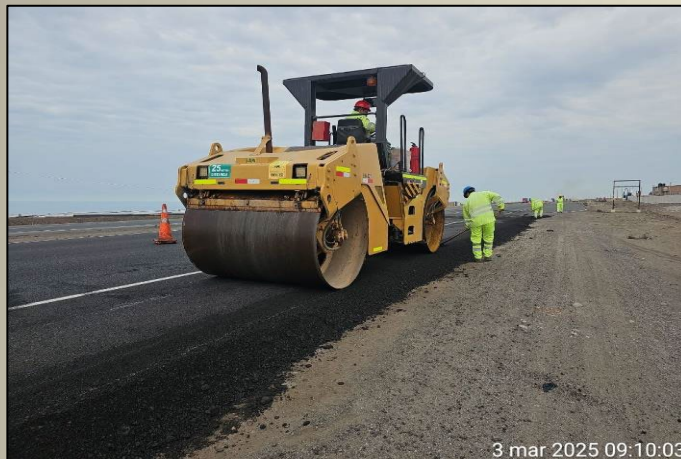
Intervención en berma – Colocación de RAF
