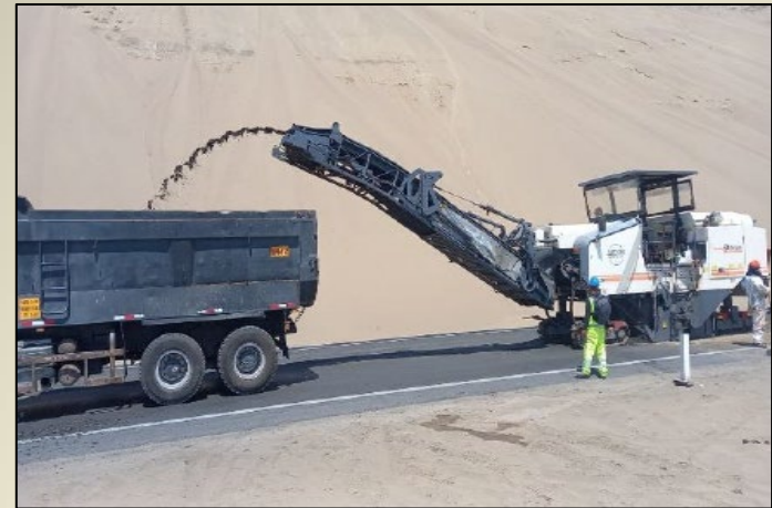
Intervención en calzada – Fresado de carpeta
