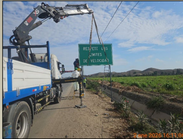
Mantenimiento de Señalización Informativa
