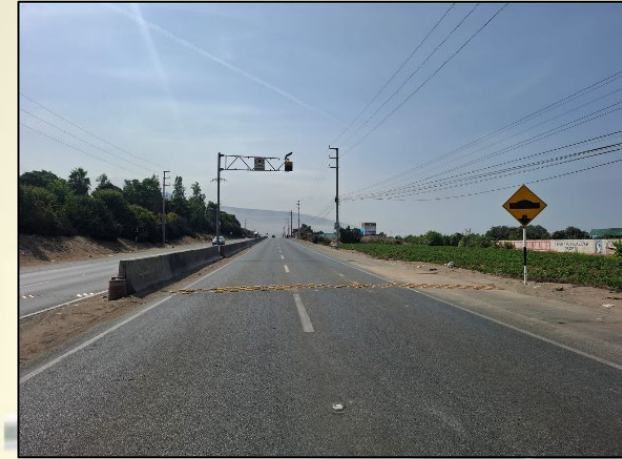
Controlador de velocidad Km 77+200 – Norte a Sur
