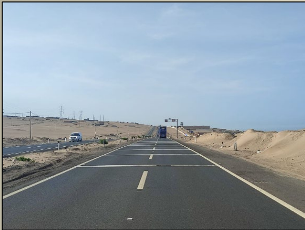
Controlador de velocidad Km 61+200 – Norte a Sur
