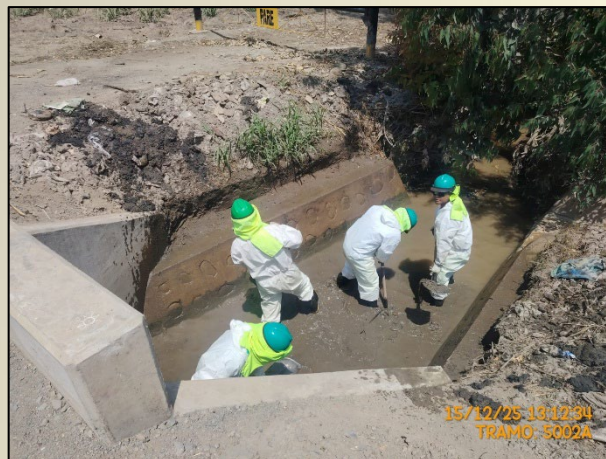
Limpieza de alcantarillas
