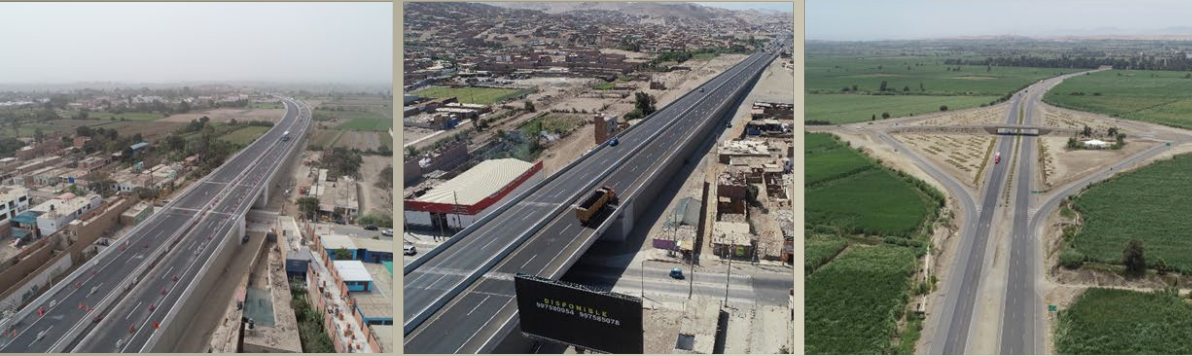
Autopista Huacho - Pativilca
