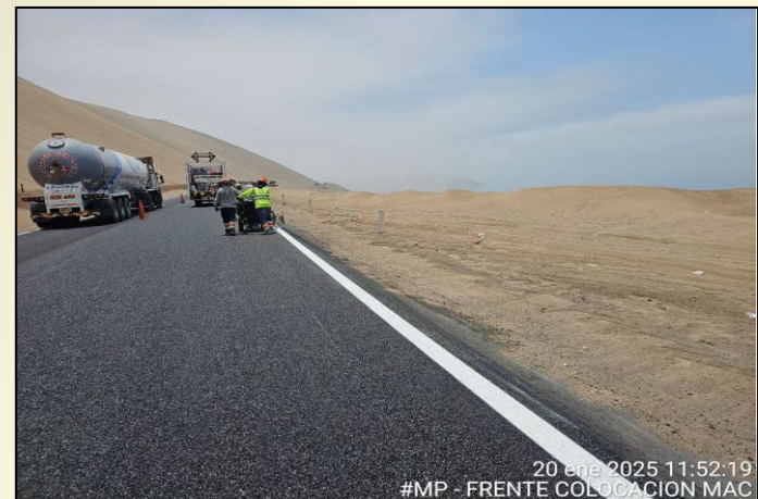
Intervención en calzada – Demarcación provisional
