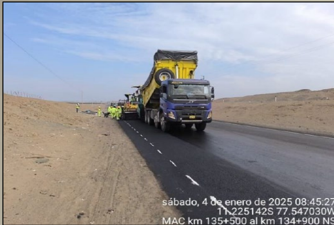
Intervención en calzada – Colocación de MAC
