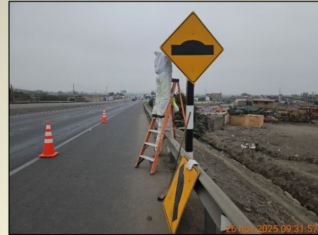
Mantenimiento de Señalización Preventiva
