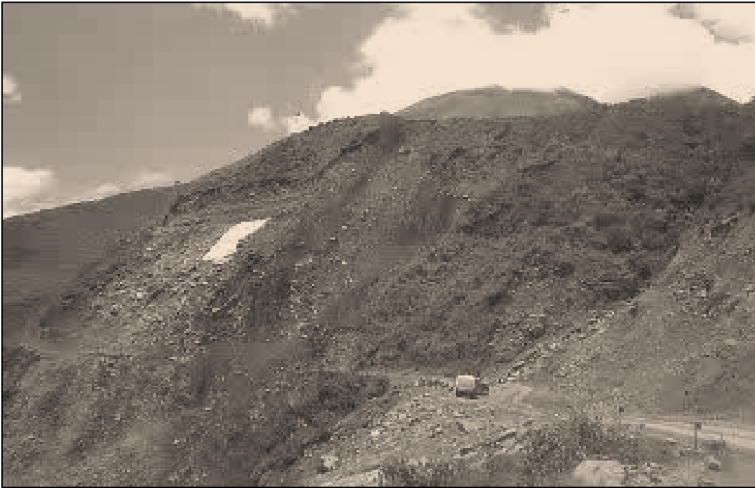
Túnel Wayrasencca (antes)
