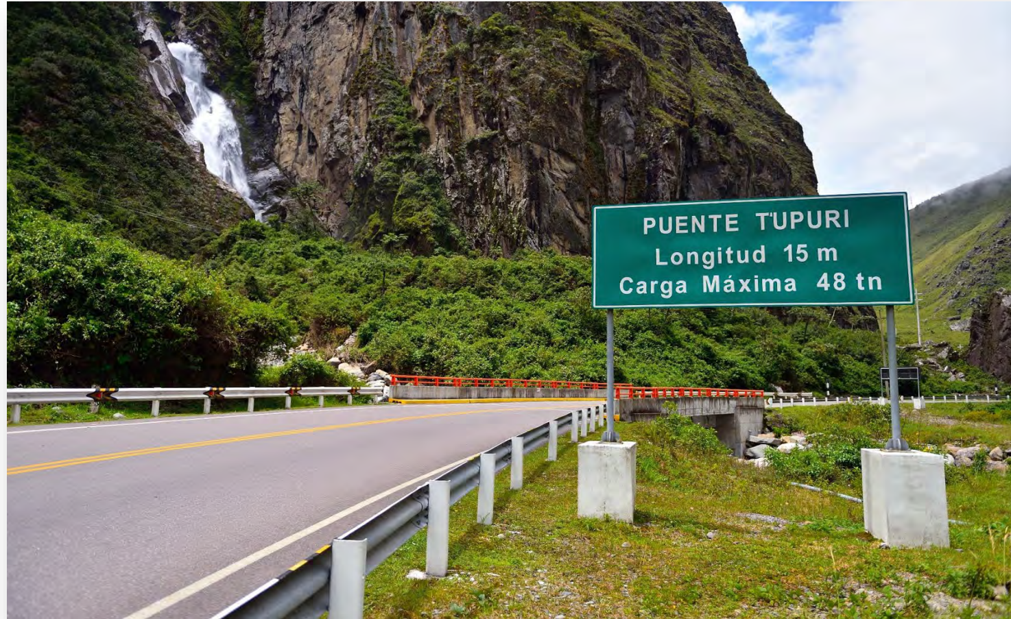
Puente Túpuri Km. 249
