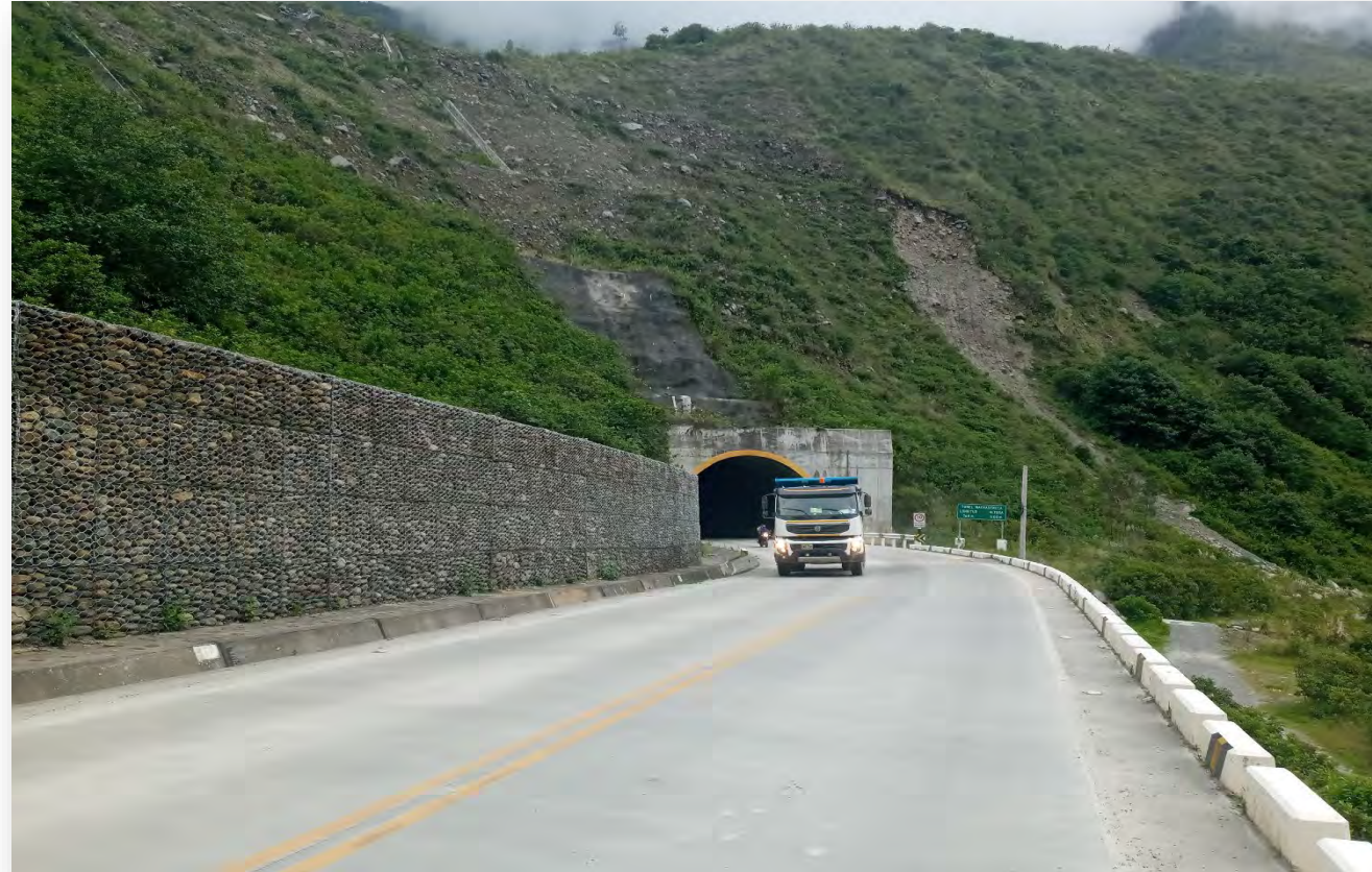
Túnel Wayrasencca Km. 237
