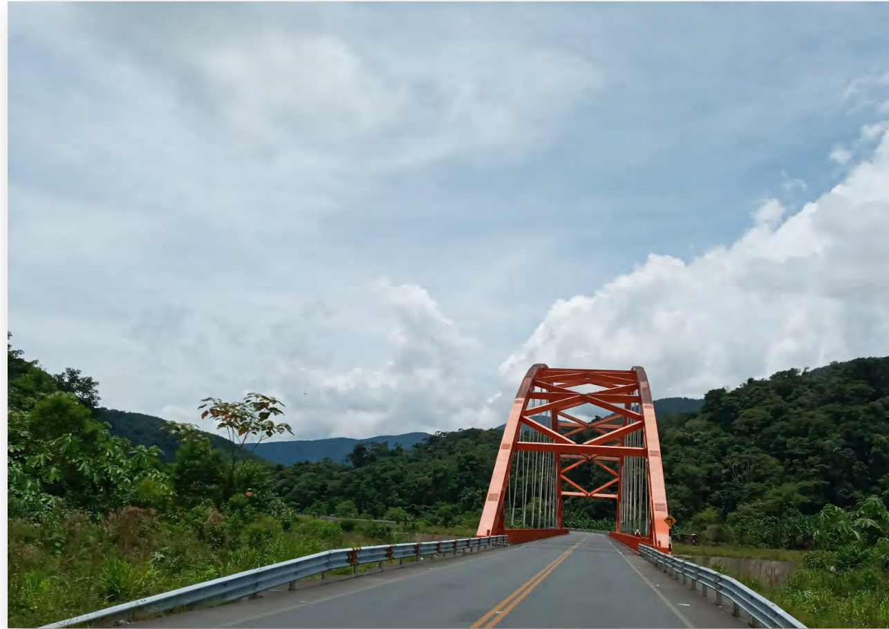
Puente Llocllamayo Km. 295
