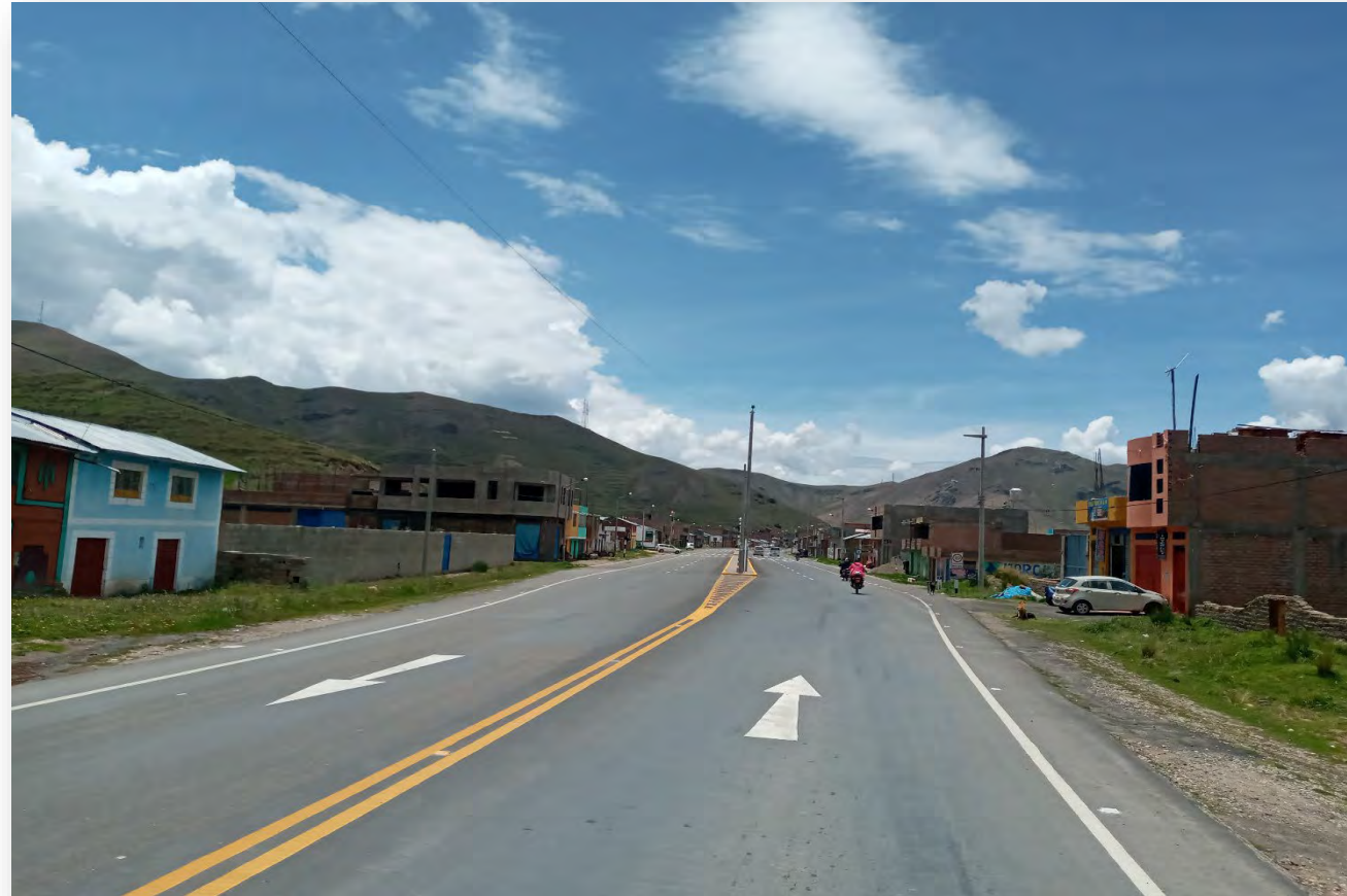
Doble vía San Antón Km. 100
