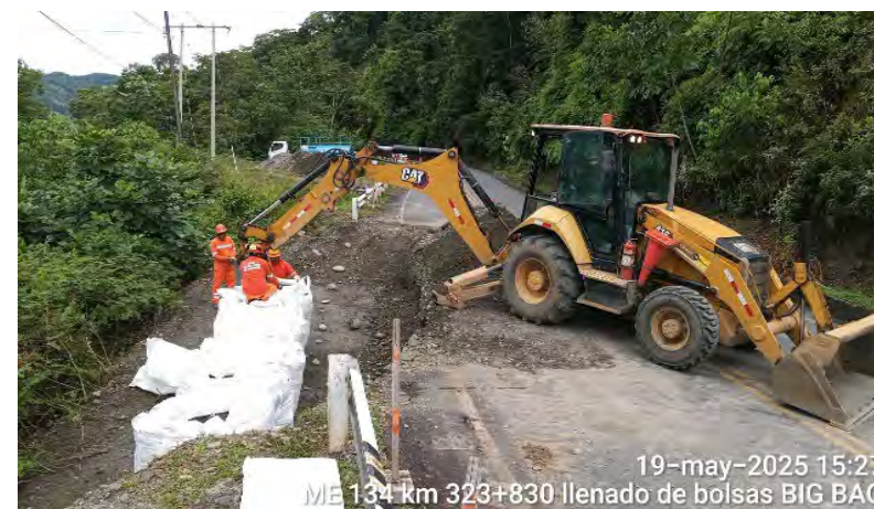
Sector crítico – reparación en calzada km 323+820
