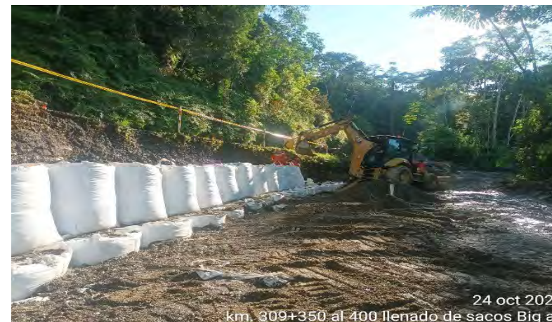
Sector crítico – Reparación de talud inferior Km 309+350
