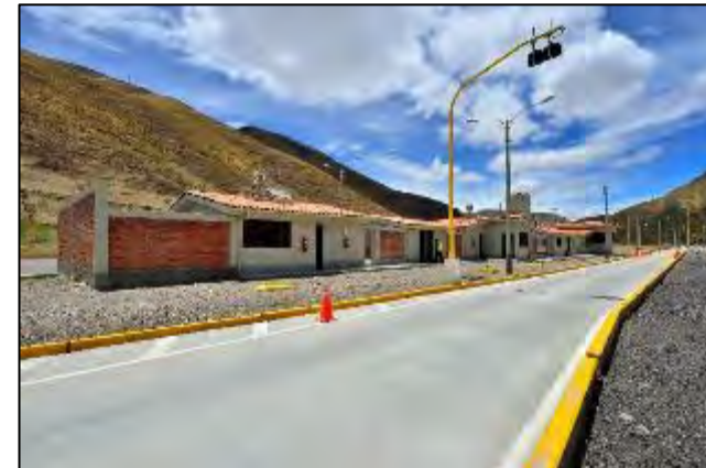
ESTACION DE PESAJE CCATUYO KM 125+500
