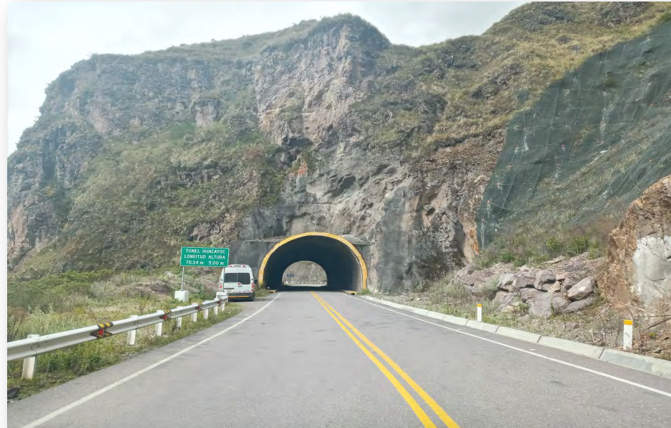
Túnel Huacayoc Km. 213
