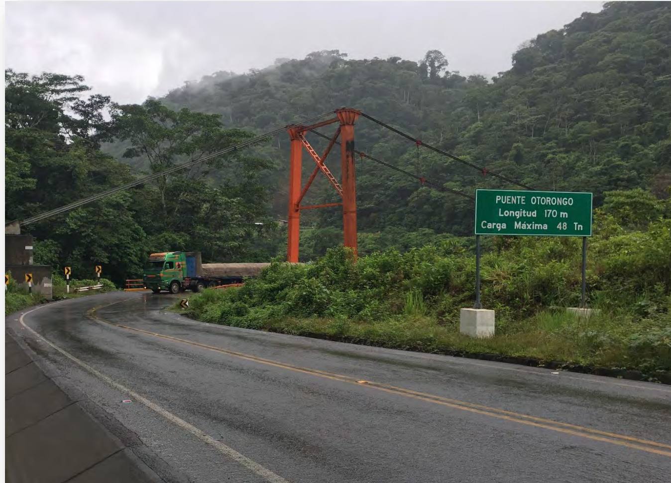
Puenete Otorongo Km. 354
