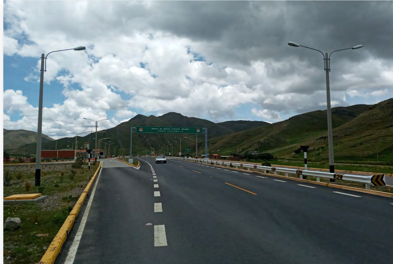
Unidad de Pesaje Ccatuyo Km. 125
