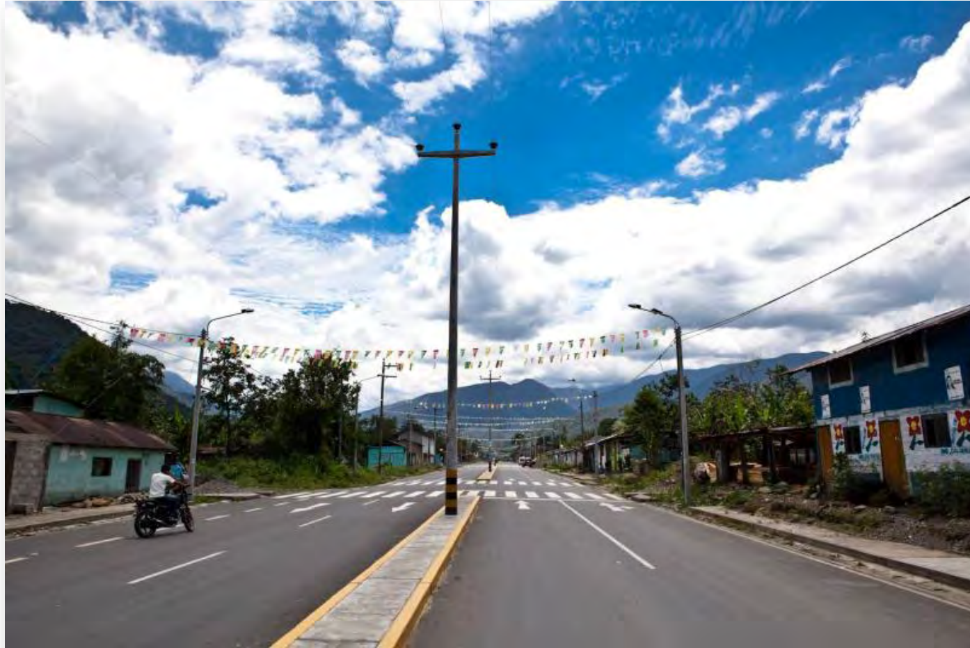
Doble Vía San Gaban Km. 292
