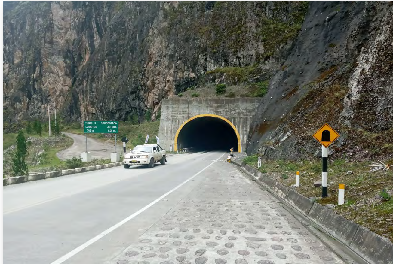
Túnel Soccostaca Km. 222
