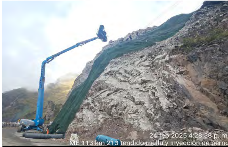
Instalación de mallas talud superior – sector Km 213+150
