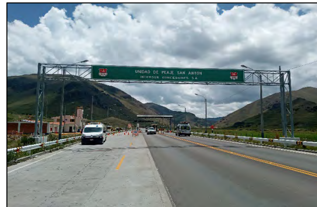
UNIDAD DE PEAJE SAN ANTON KM 107 + 300
