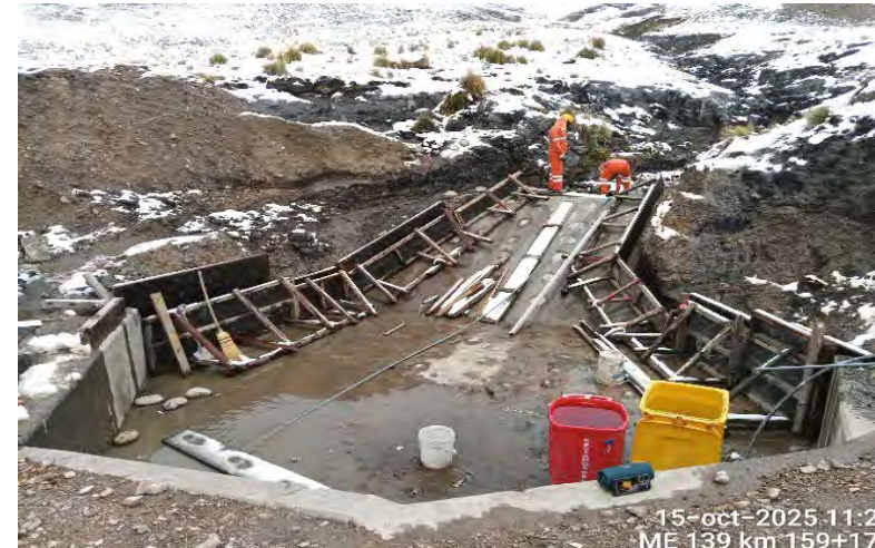
Reparación de alcantarilla – Sector km 159+170
