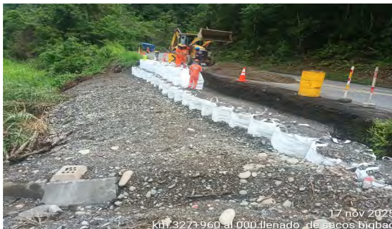
Sector crítico – Reparación de talud inferior Km322+060
