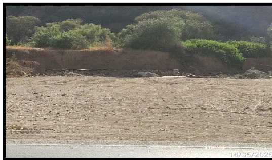
DME – Km. 047+100 SUB TRAMO 1
