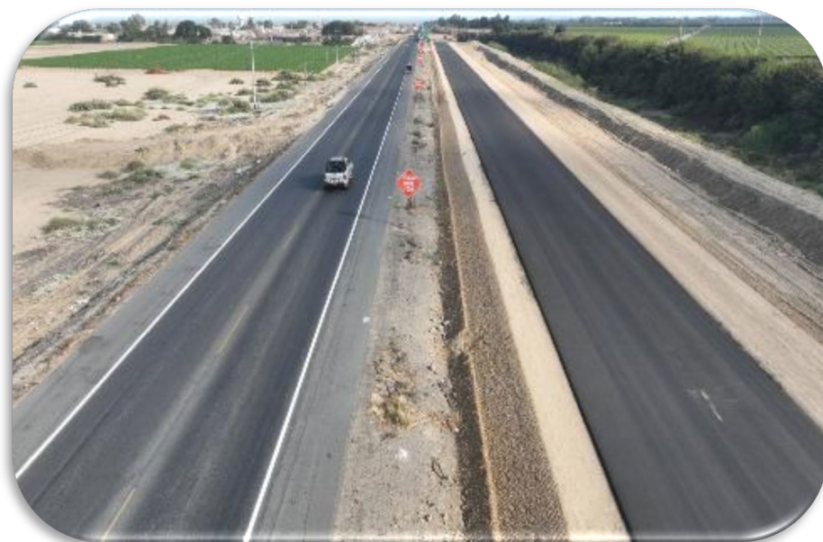
Tramo Continuo San Jose de Moroc - Mocupe: 72.50%
