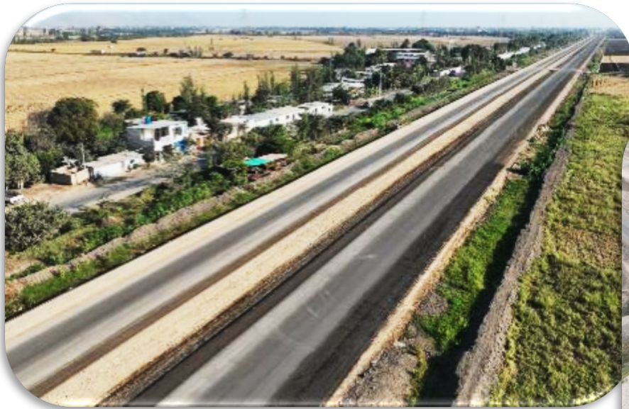
Del Km 702+000 al Km 717+800
