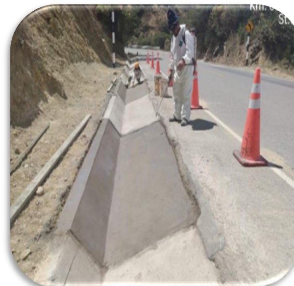
Fotografía 03: Reposición de cunetas – Sub tramo 02
