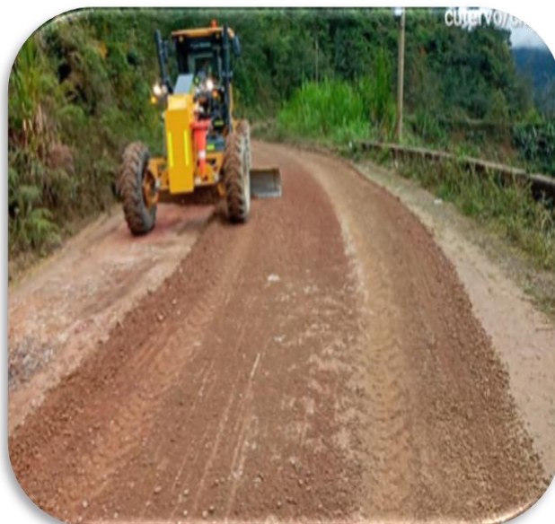
Fotografía 01: Mto. de Tránsito Temporal en sectores no asfaltados – Sub tramo 01
