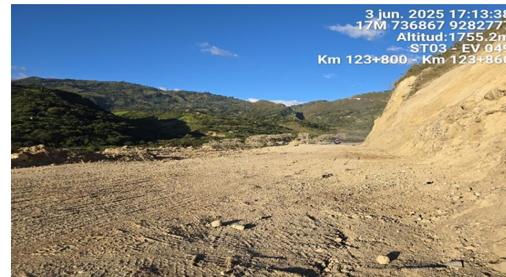
Limpieza de derrumbes
