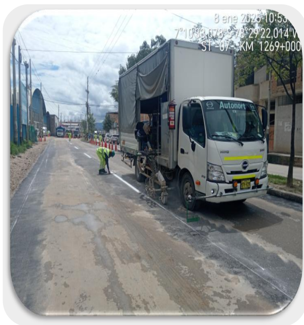
Fotografía 10: Transitabilidad – Sub tramo 07
