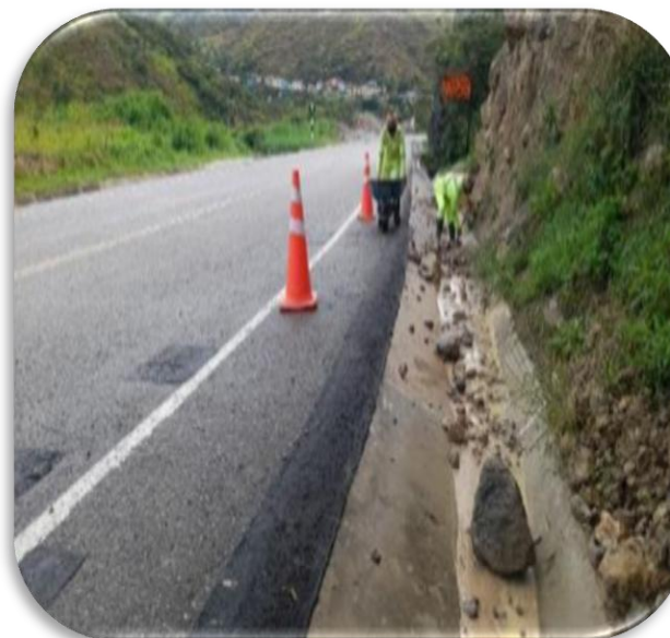
Fotografía 02: Limpieza de cunetas – Sub tramo 02
