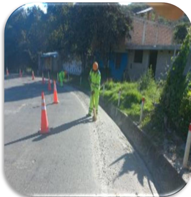
Fotografía 16: Limpieza de calzada y bermas – Sub tramo 09
