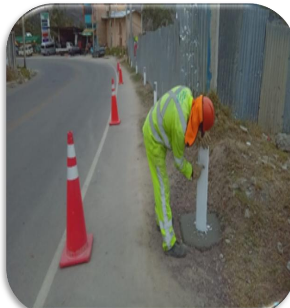
Fotografía 17: Conservación de delineadores – Sub tramo 04
