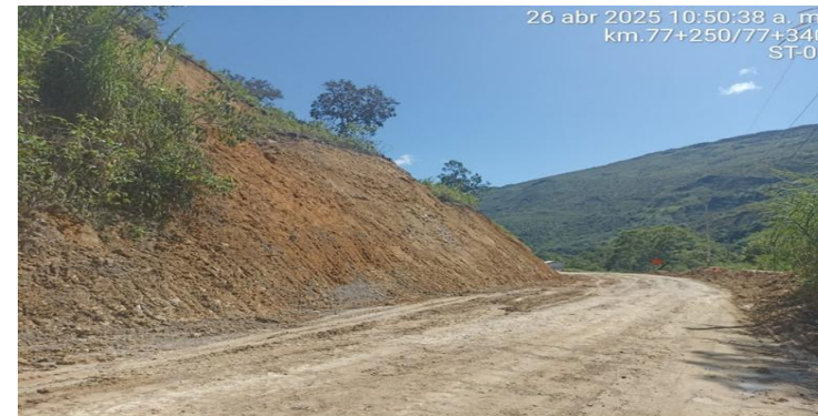
Limpieza de derrumbes
