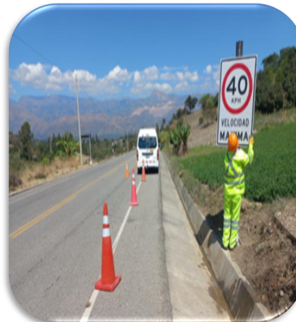
Fotografía 18: Reposición de panel vertical – Sub tramo 09
