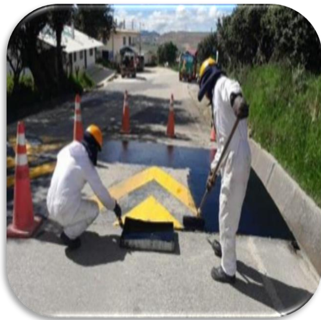
Fotografía 13: Pintado de gibas – Sub tramo 05
