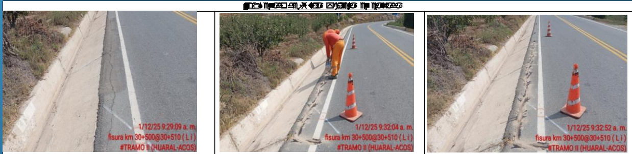
Sello de Fisuras
