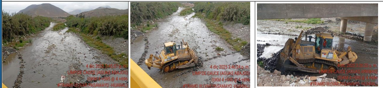
1102 LIMPIEZA DE PUENTES
