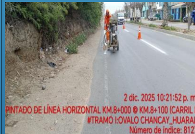
807 MANTENIMIENTO DE MARCAS EN EL PAVIMENTO
