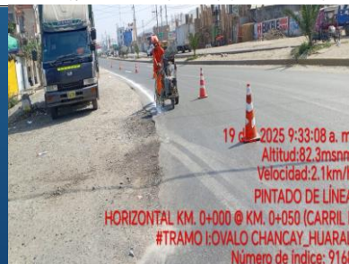
807 MANTENIMIENTO DE MARCAS EN EL PAVIMENTO
