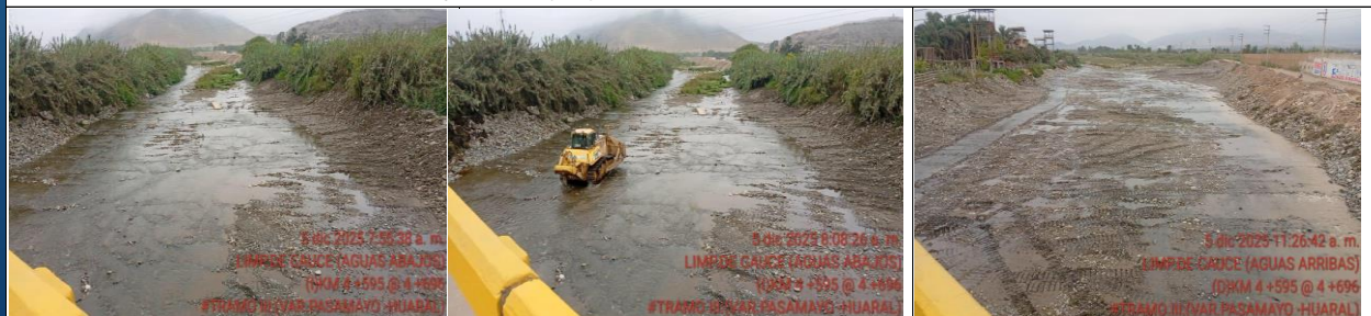
1102 LIMPIEZA DE PUENTES
