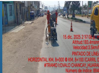
807 MANTENIMIENTO DE MARCAS EN EL PAVIMENTO
