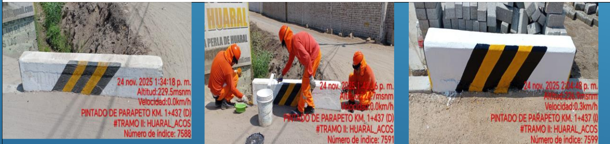
808 CONSERVACIÓN DE PINTADO DE CABEZALES DE ALCANTARILLAS.
