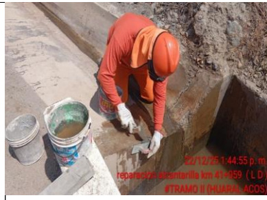
620 REPARACIÓN DE CABEZALES DE ALCANTARILLAS
