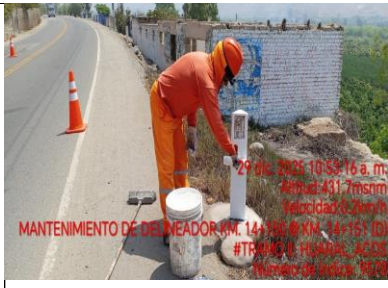
824 CONSERVACIÓN DE OTROS ELEMENTOS DE SEGURIDAD VIAL (POSTES DELINEADORES)
