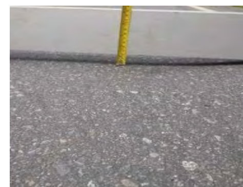
Deterioro en el Pavimento por filtraciones
