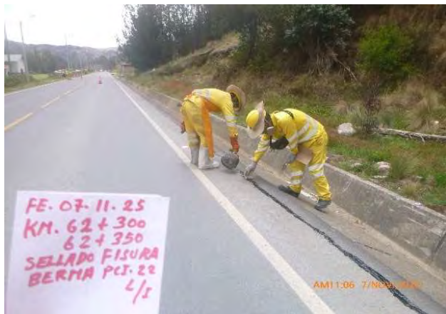
Tratamiento de fisuras
