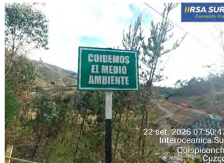
Instalación de señalización Ambiental
