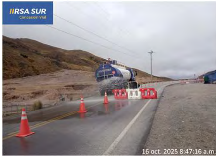
Control de contaminación mediante riego de vías
