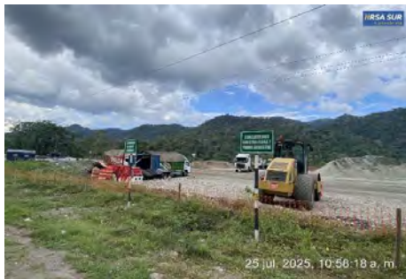
Implementación de señalización Ambiental
