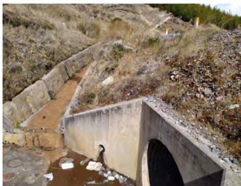
Deterioro del drenaje
