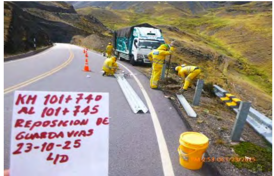
Reposición de guardavía
