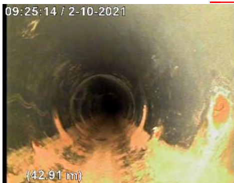
Deterioro del drenaje
