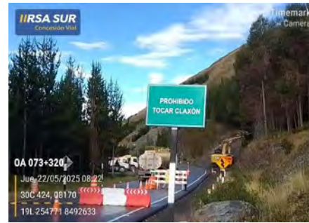
Instalación de señalización Ambiental
