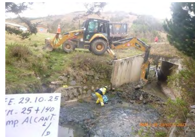
Limpieza de superficie de concreto y dispositivos de drenaje
