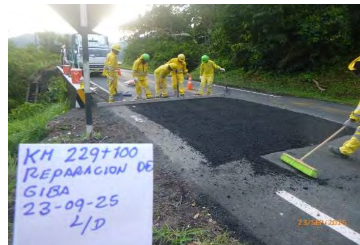
Reparación de bache superficial
