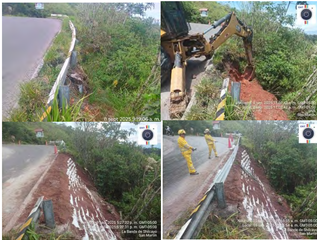
Trabajos de protección del talud de plataforma Km 17+280
