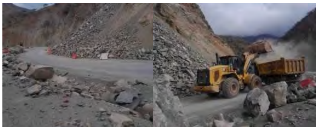
Limpieza de deslizamiento Km. 55+200
