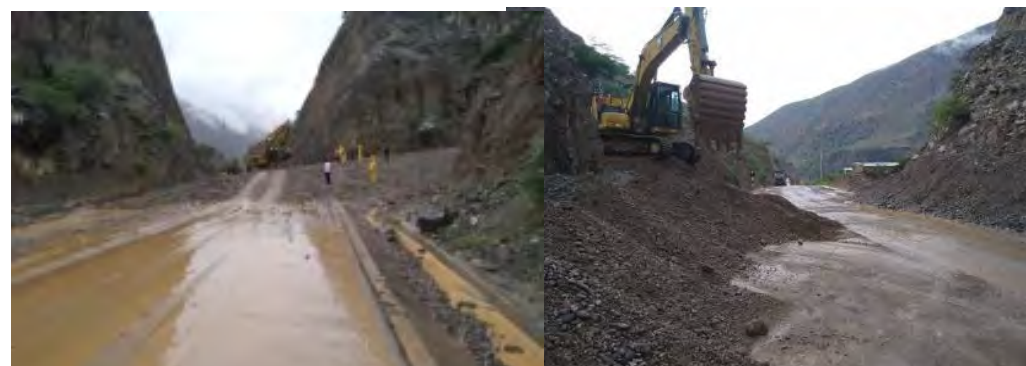
Limpieza de Activación de quebrada Km 66+400
