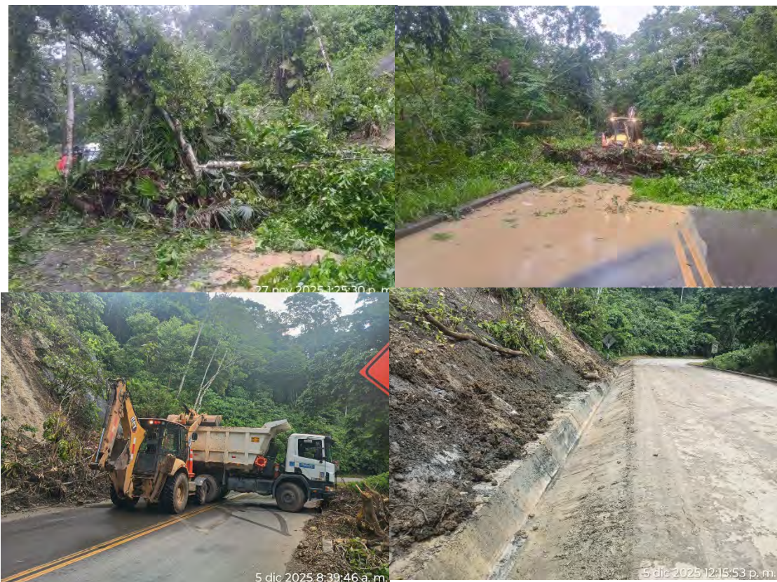
Trabajos de protección del talud de plataforma Km 28+200
