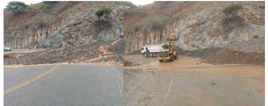
Limpeza de activación de quebrada Km. 58+700
