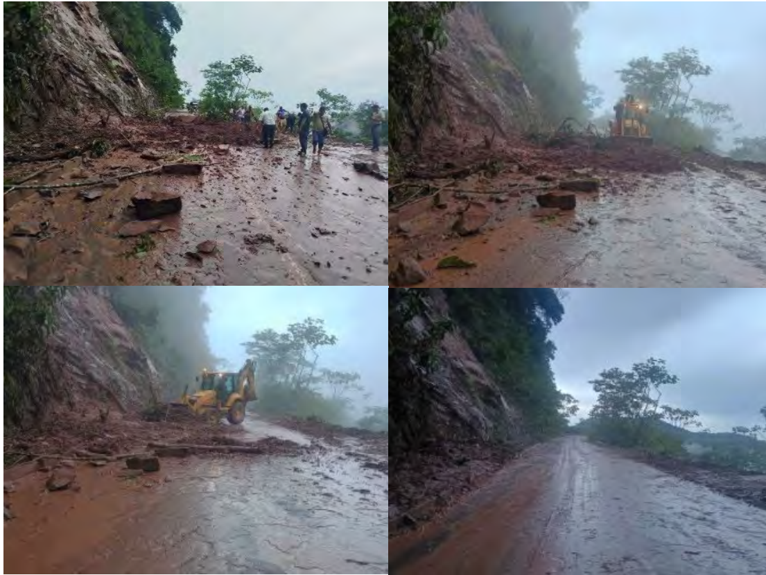
Limpieza de Deslizamiento de material Km 13+200
