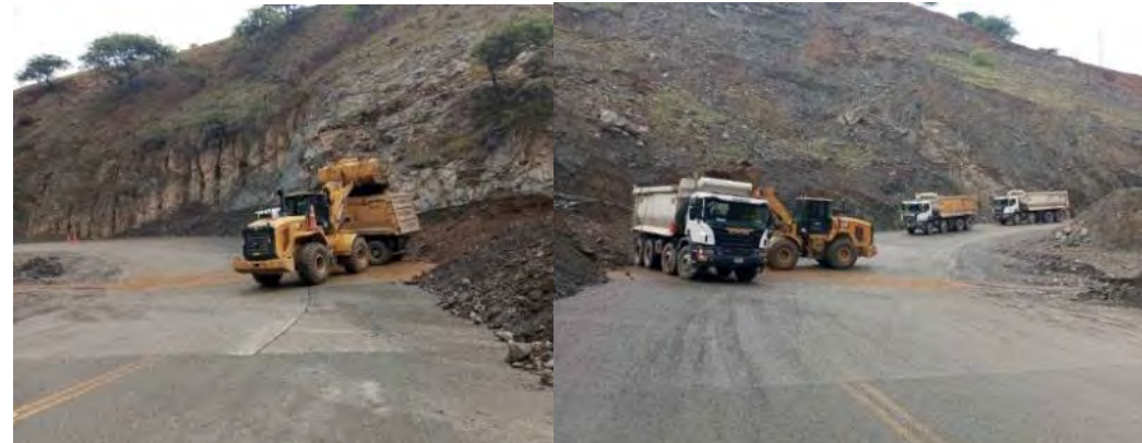
Limpieza de Deslizamientos Km 58+700
