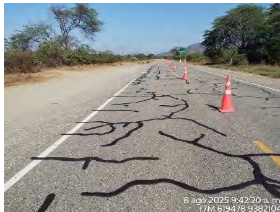
Sellado de fisuras
