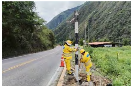
Reposición de postes de señales
