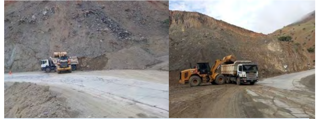
Limpeza de Deslizamientos Km 57+300
