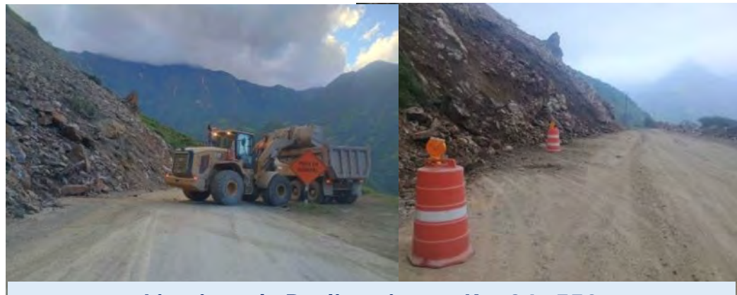
Limpieza de Deslizamientos Km 34+550
