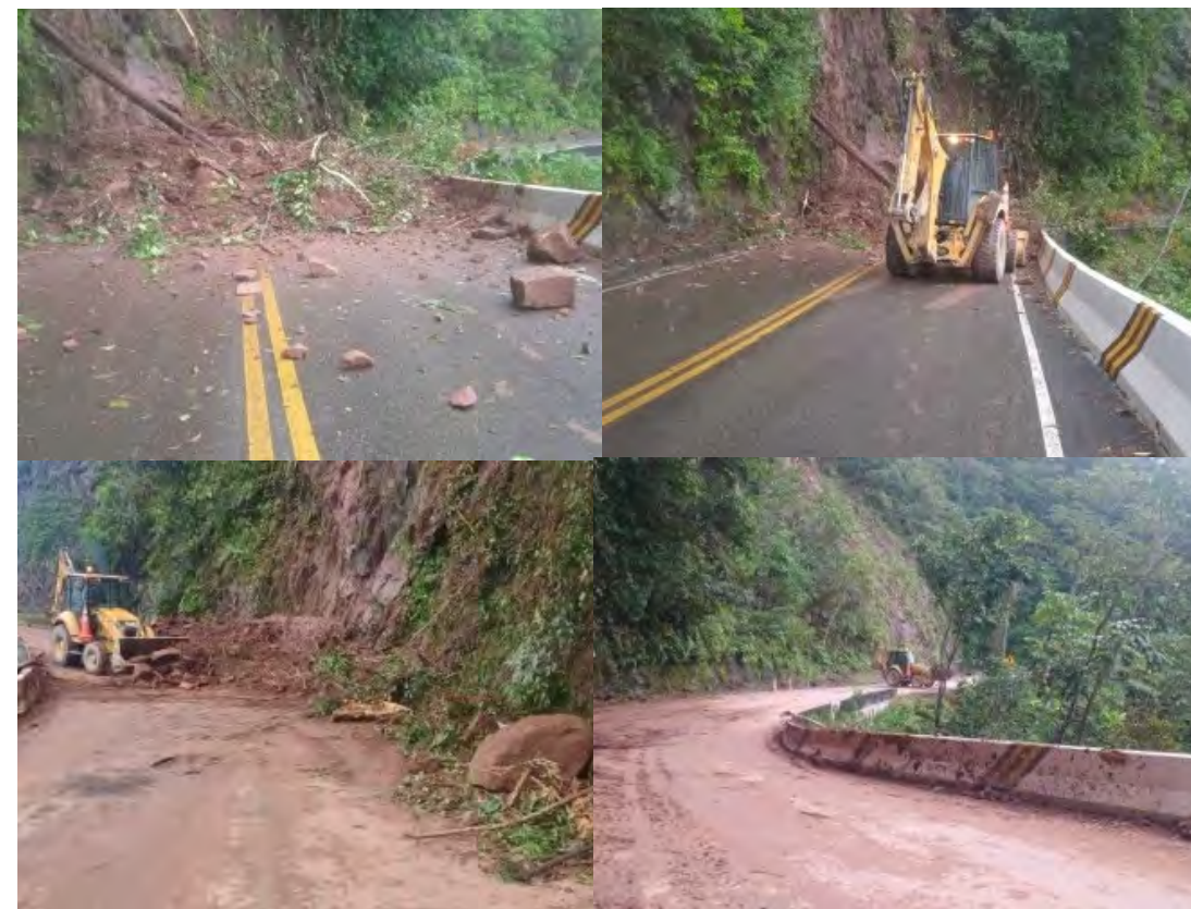
Limpieza de Deslizamiento de material Km 20+250
