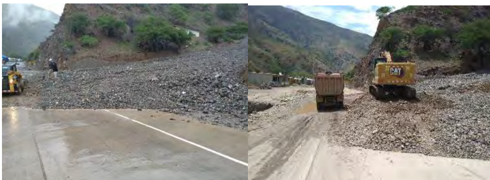
Limpieza de Activación de quebrada Km. 68+400
