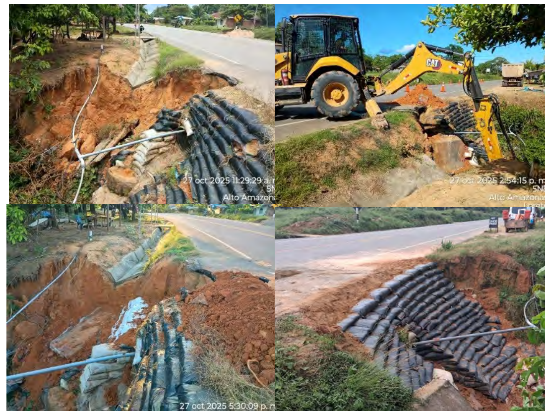
Trabajos de protección del talud de plataforma Km 109+700
