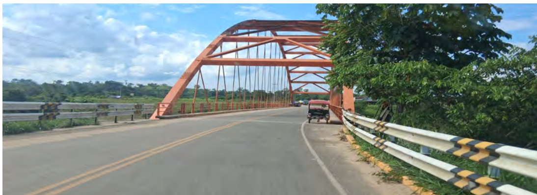
ITM Puente Parapapura km 4+360 – Tramo 01
