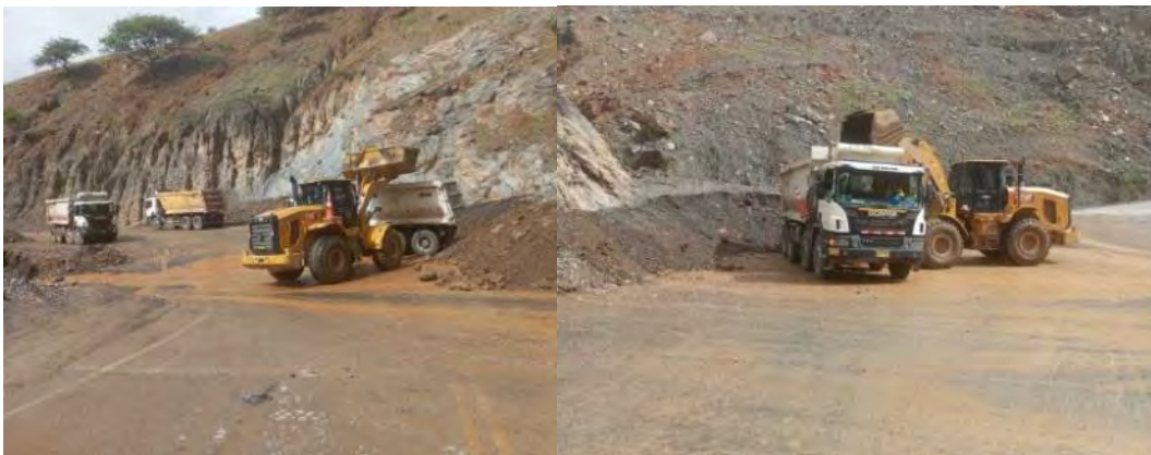
Limpeza de activación de quebrada Km. 58+700
