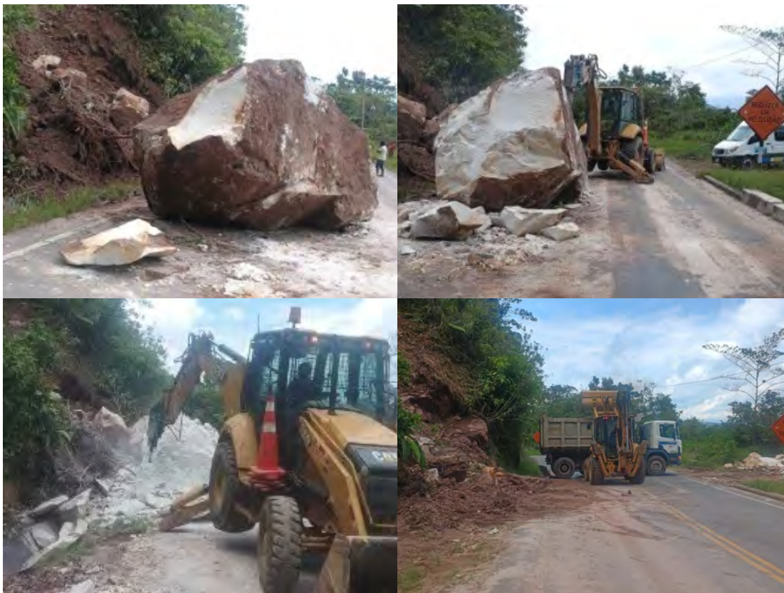
Trabajos de protección del talud de plataforma Km 19+730
