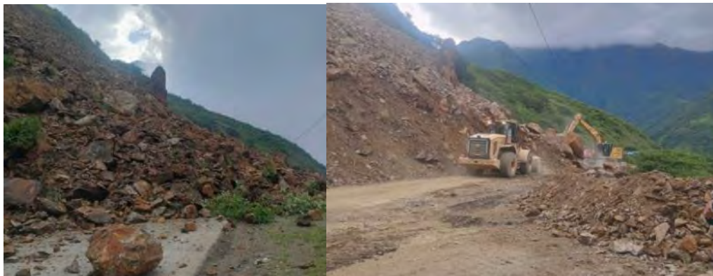
Limpieza de Desprendimientos de rocas Km 34+550
