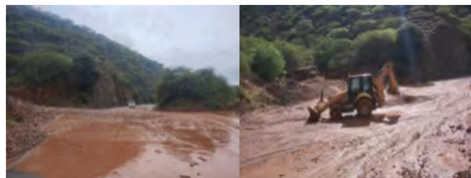
Limpieza de Activación de quebrada Km. 91+850
