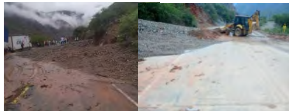
Limpieza de Activación de quebrada Km 82+900
