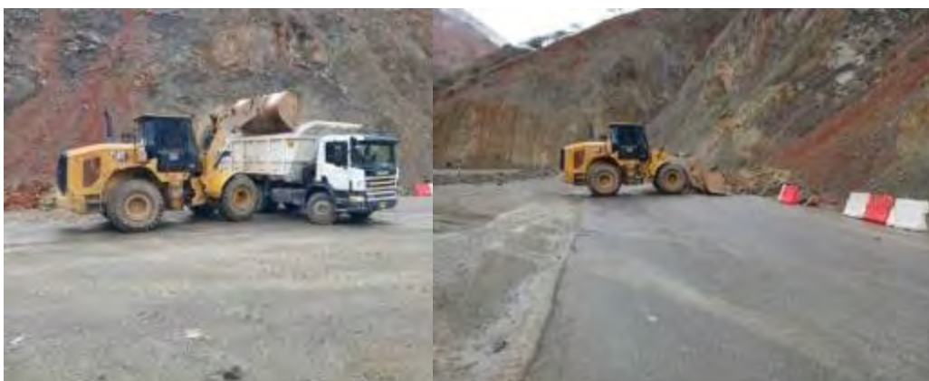
Limpieza de deslizamiento Km. 55+200
