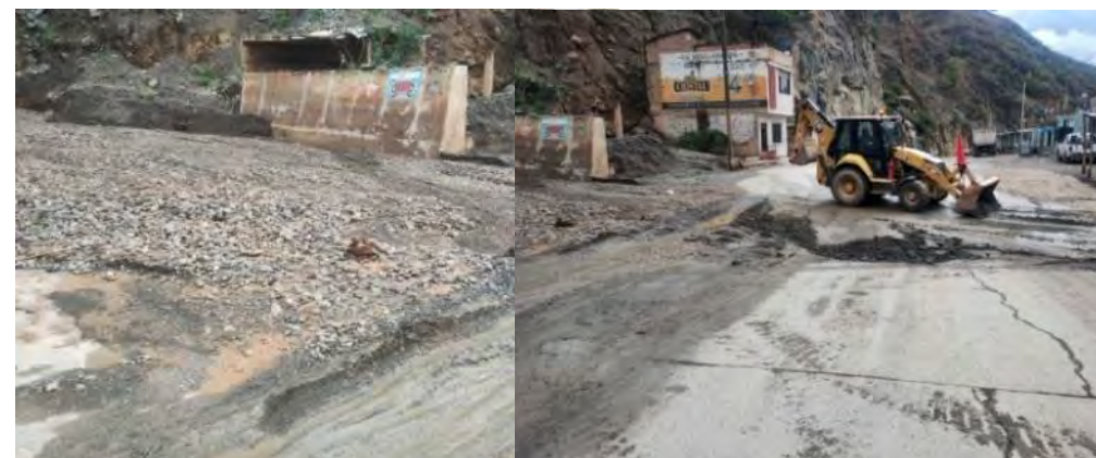
Limpieza de Activación de quebrada Km. 60+700
