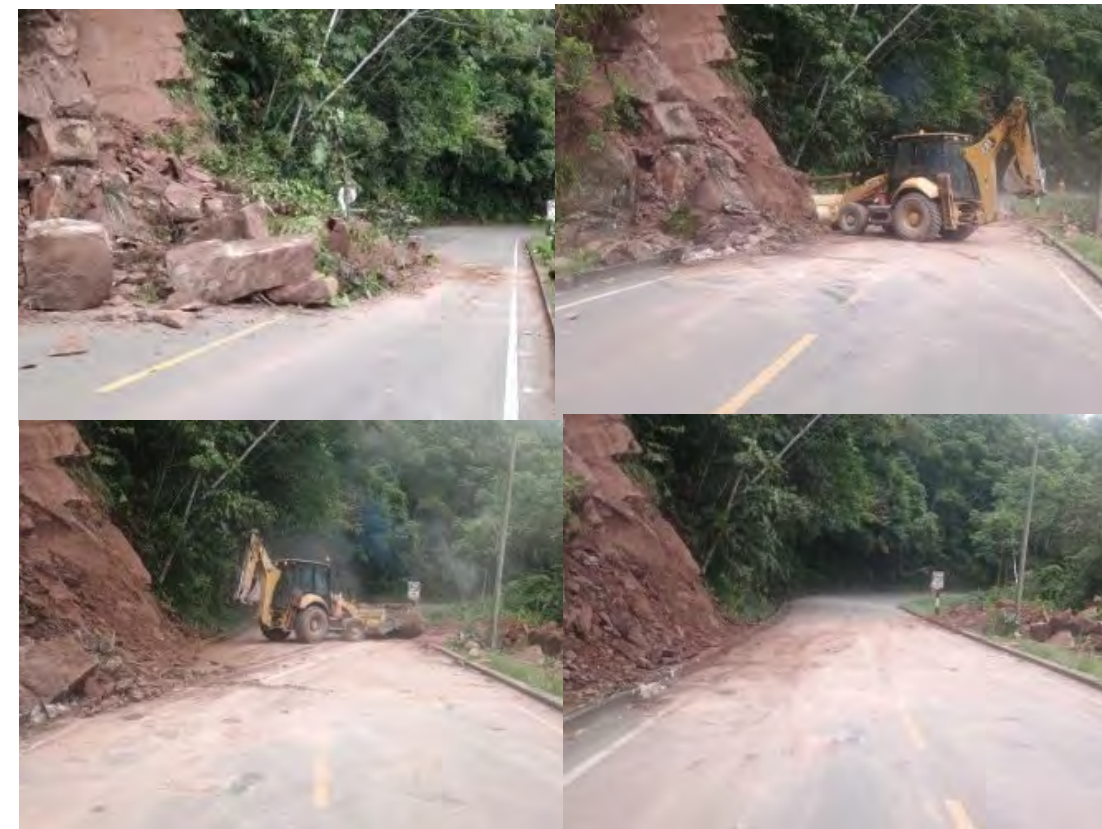
Limpieza de Deslizamiento de material Km 19+650
