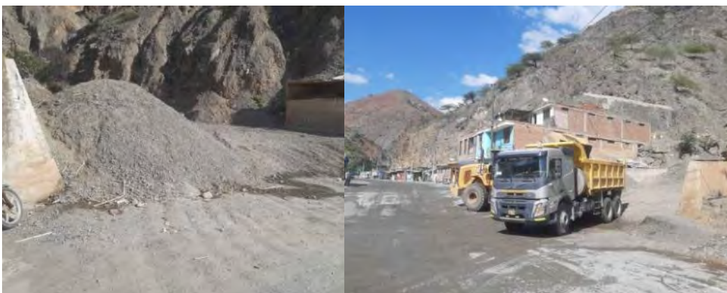
Limpieza de Activación de quebrada Km. 60+700
