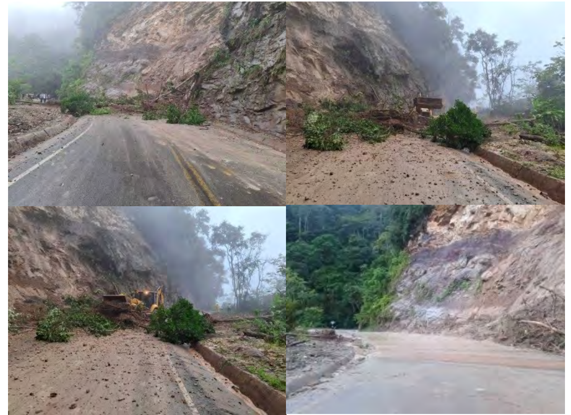
Limpieza de Deslizamiento de material Km 13+600
