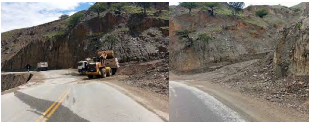
Limpieza de activación de quebrada Km. 56+500
