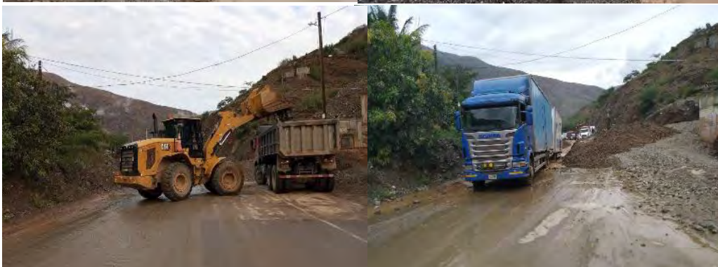
Limpieza de Activación de Quebrada Km 68+990
