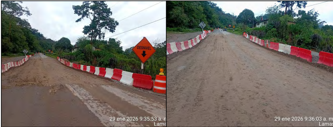
Trabajos de reemplazo de TMC - ITM de Drenaje Km 541+578 – Tramo 02
