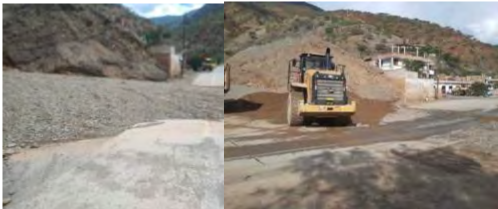
Limpieza de activación de quebrada Km. 68+990
