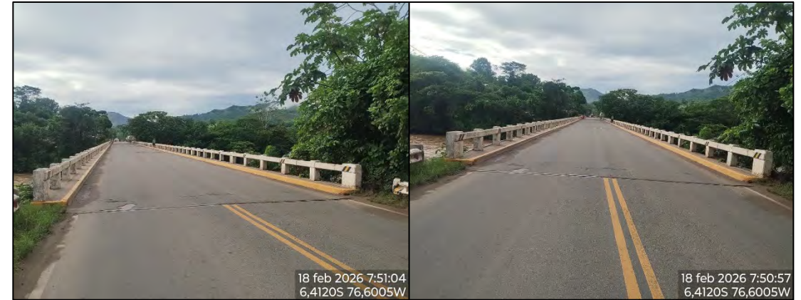
ITM Puente Bolivia km 573+200 – Tramo 02
