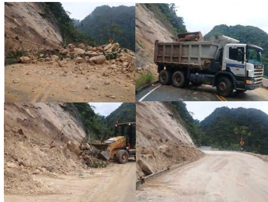
Limpieza de Deslizamiento de material Km 33+3000
