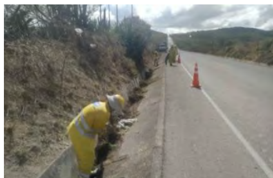
Limpieza de cunetas
