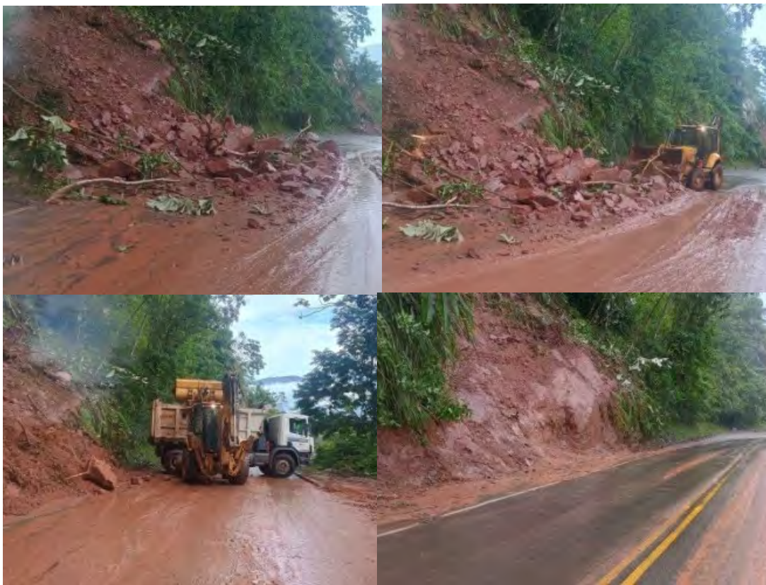
Trabajos de protección del talud de plataforma Km 22+010
