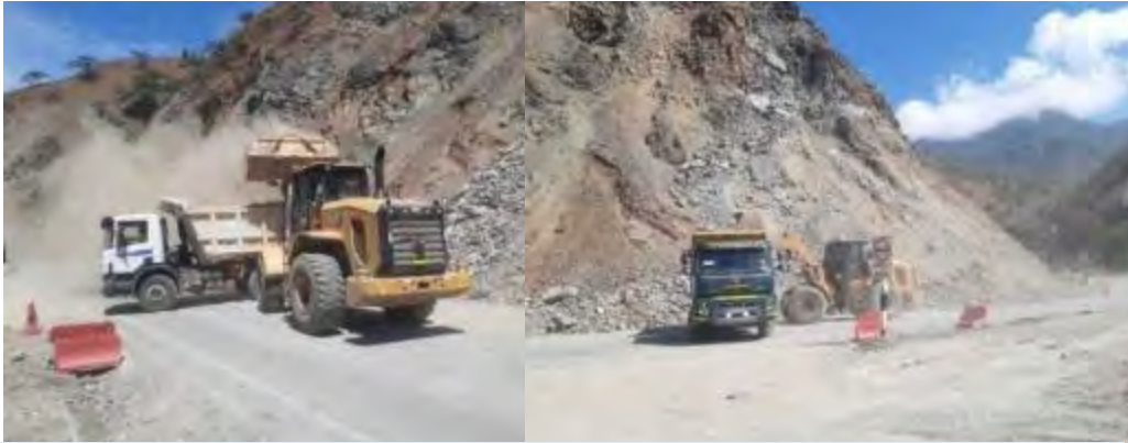
Limpeza de deslizamiento Km. 55+200
