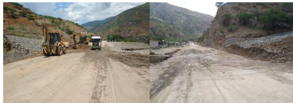
Limpieza de Activación de quebrada Km. 68+400
