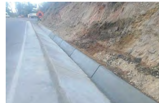
Reparación de paños de cuneta
