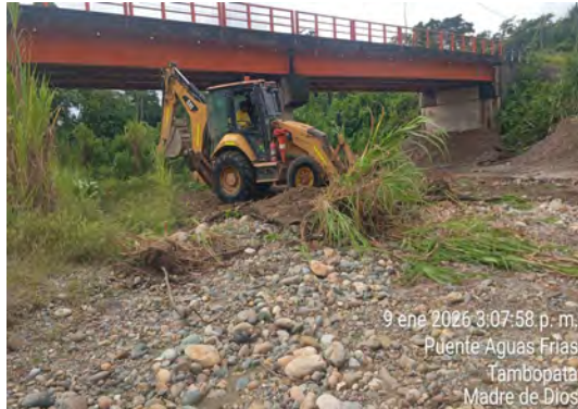
Limpienza de cauce Puentes
