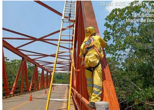
Limpienza de Estructura reticulada
