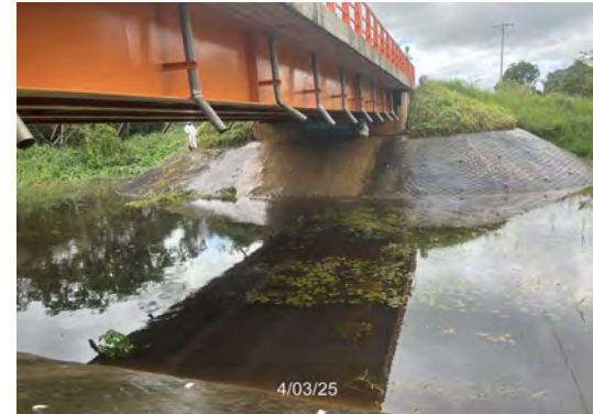
Lavado de vigas
