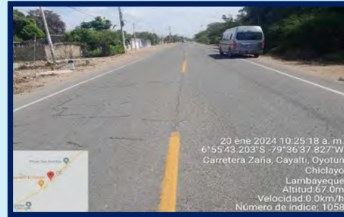
DESPUÉS - KM 07+000 AL KM 08+000
