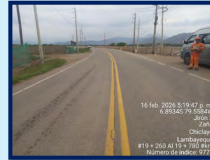
EXCESO O DECOLORACIÓN DE LOS EJES LD – LI y EJE CENTRAL
