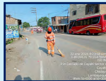
Limpieza de Berma y Calzada
