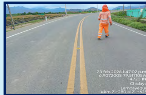
DESPUÉS - KM 21+000 AL KM 22+000
