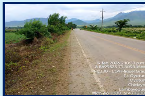
DESPUES - KM 47+000 AL KM 47+847
