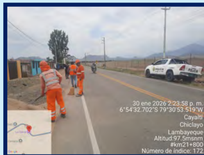
LIMPIEZA DE OBSTACULOS
