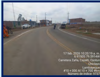
DECOLORACIÓN DE LAS LÍNEAS O MARCAS LD-EJE -LI
