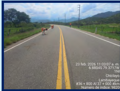
Tratamiento de fisuras
