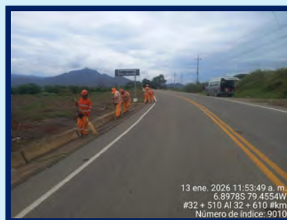
Limpieza de cuneta de vía
