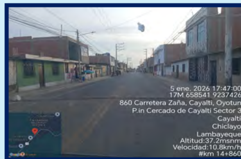
DESPUÉS - KM 14+000 AL KM 15+000
