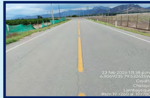
DESPUÉS - KM 19+000 AL KM 20+000
