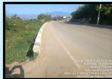
27 MTS DE MURO
