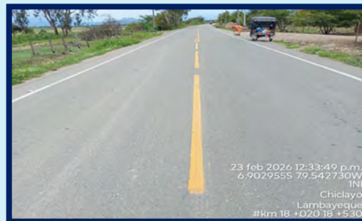
DESPUÉS - KM 18+000 AL KM 19+000
