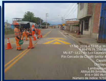
DECOLORACION O SUCIEDAD DE LINEAS O MARCAS (GIBAS)
