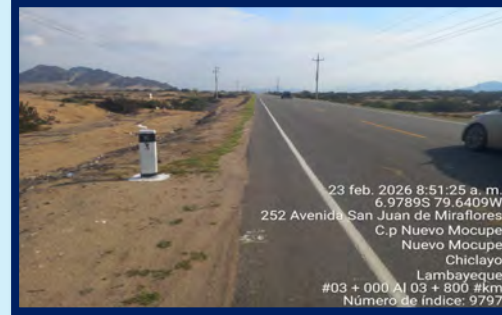
DESPUÉS - KM 02+000 AL KM 03+000
