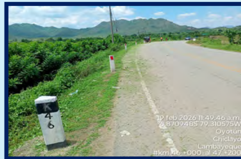
DESPUÉS - KM 46+000 AL KM 47+000
