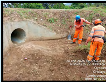
LIMPIEZA DE ALCANTARILLA
