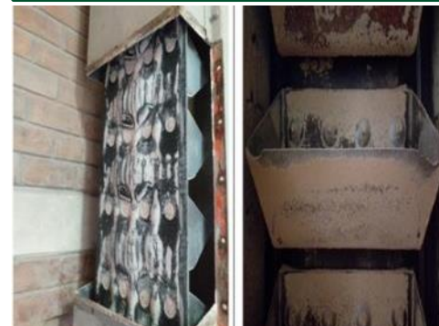
Cambio de Bandas Etapa II del Sistema de Granos
