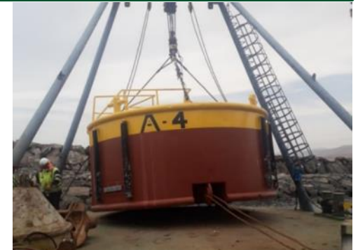
Cambio de sinker e implementación de grilletes giratorios en boyas.
