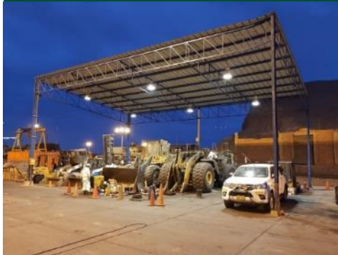
Implementación de techo para el taller de Equipo Motorizado.
