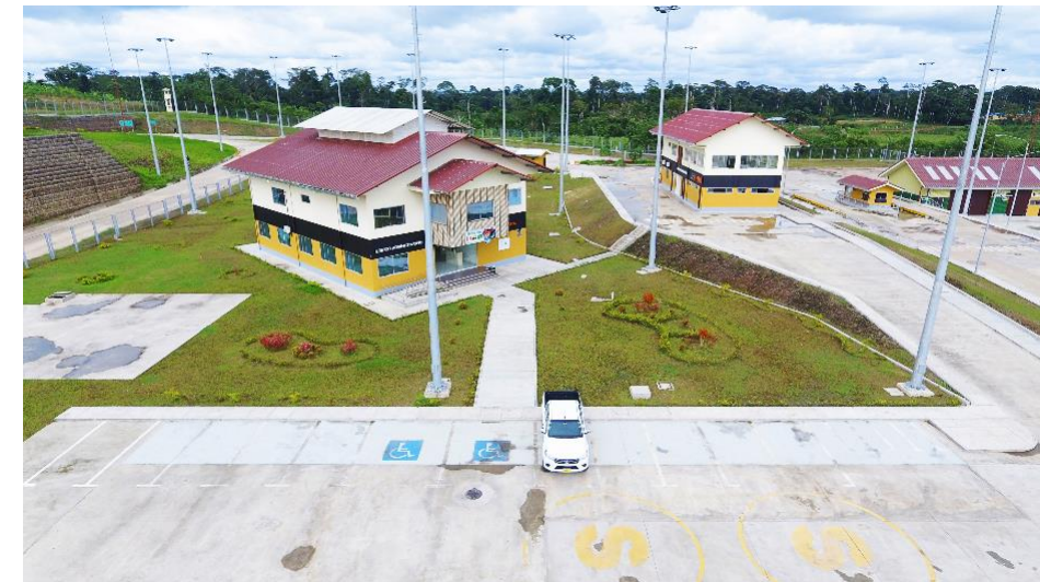
Vista panorámica del Edificio Administrativo del TPY-NR FASE I
