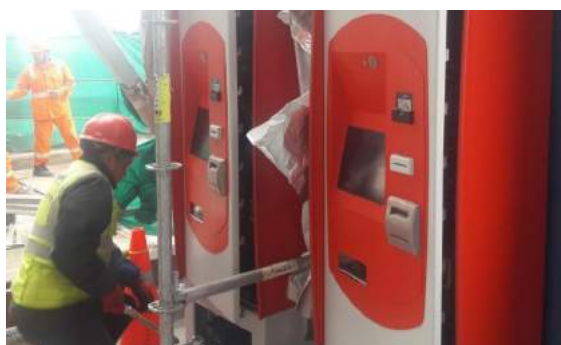
Instalación de máquinas de recarga.
