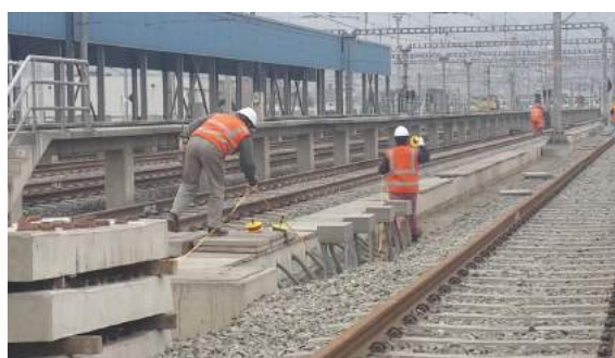
Ampliación del patio de maniobras.
