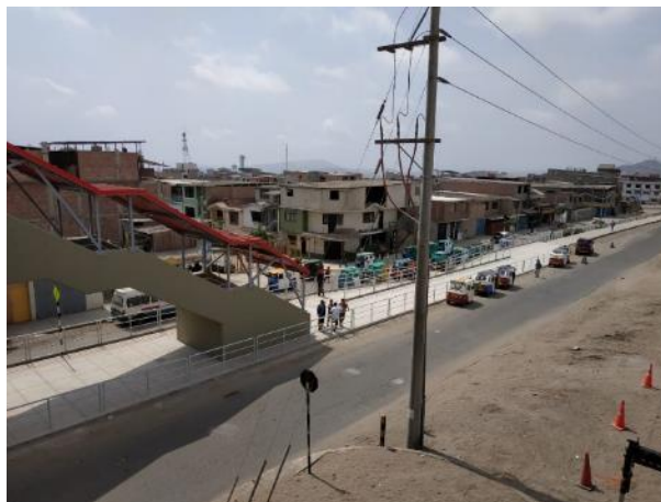
Nueva Escalera Concreto
