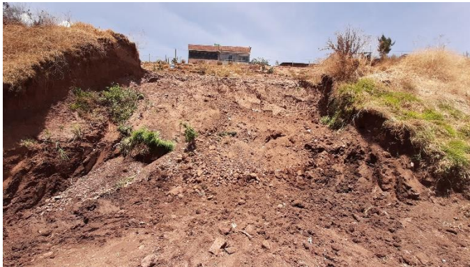
Estabilización de talud inferior Km 335+200 tramo Juliaca - Cusco
