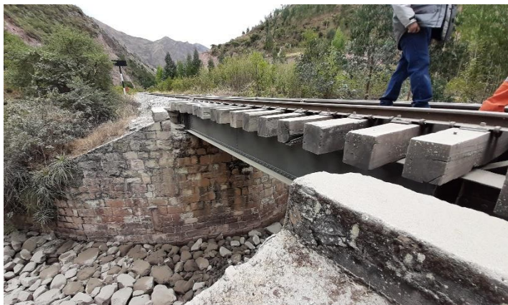
Puente Parpiso SD 07
