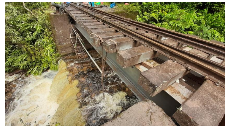
Puente Km 115+404 SD 07
