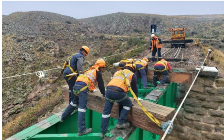
Puente N°11 Km 68.020 tramo Arequipa - Juliaca
