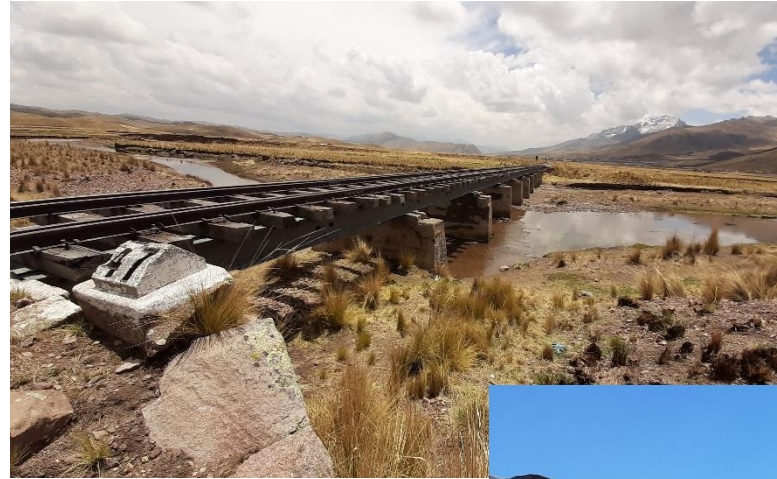
Puente Pancca SD 06
