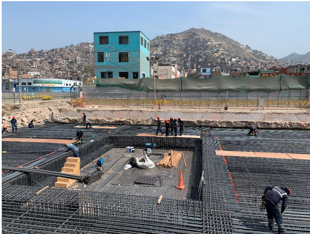
Colocación de armadura en losa de cubierta
