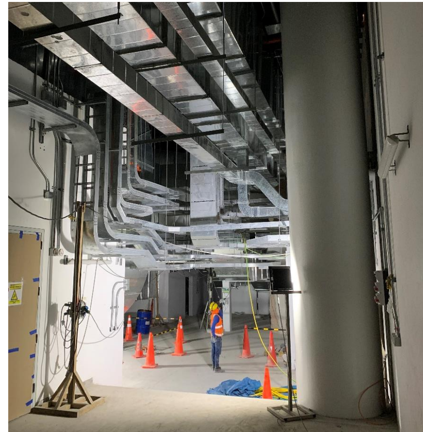
Instalación de Bandejas
