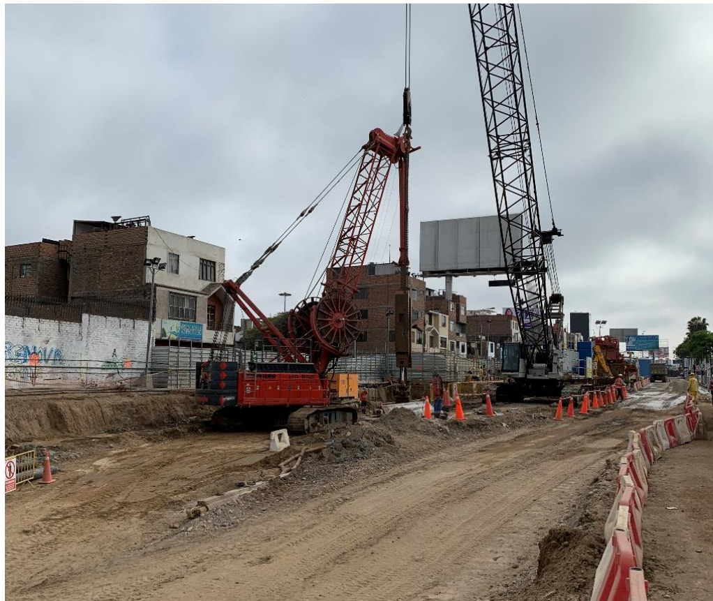
Ejecución de Pantallas
