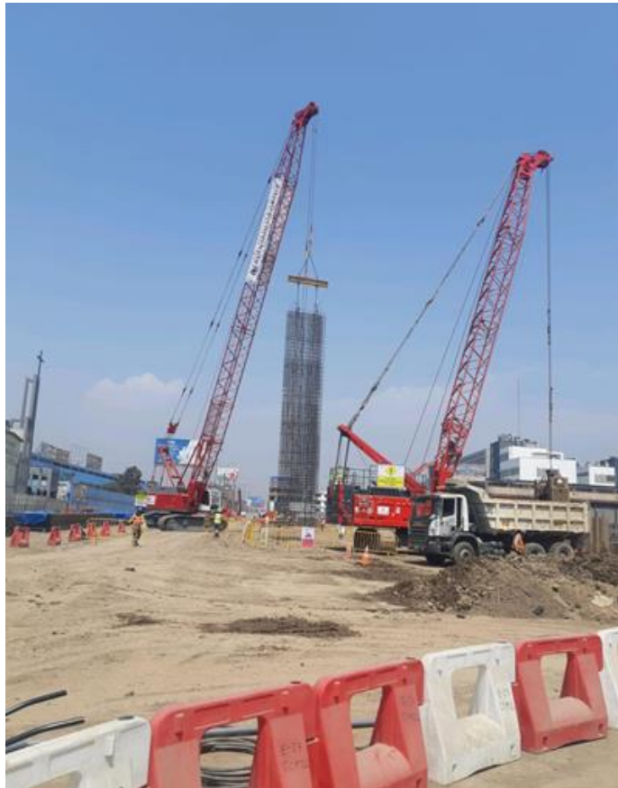
Ejecución de Pantallas.
