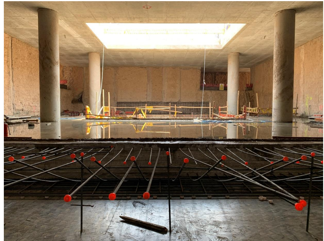
Inicio losa de vestibulo
