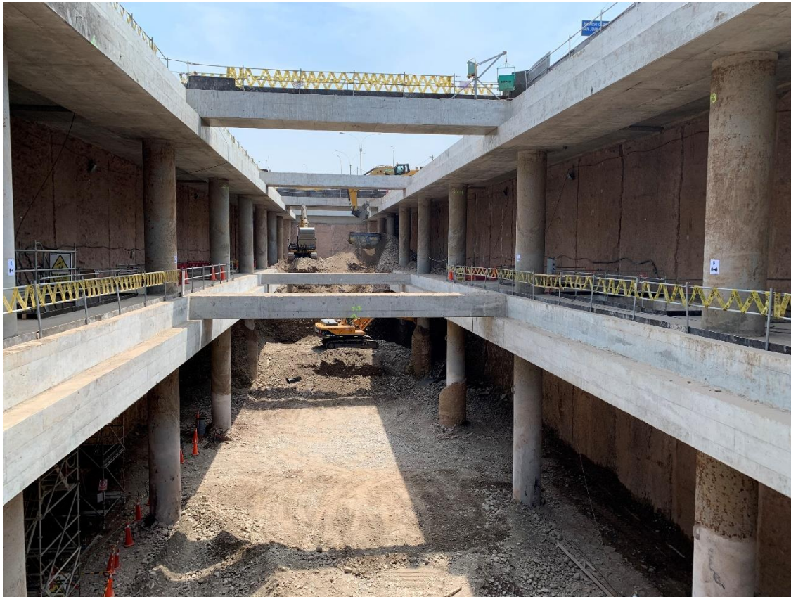
Excavación Losa de Fondo.
