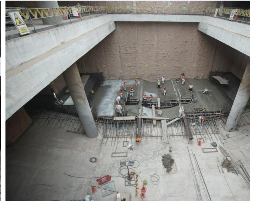
Preparación losa de fondo para TBM
