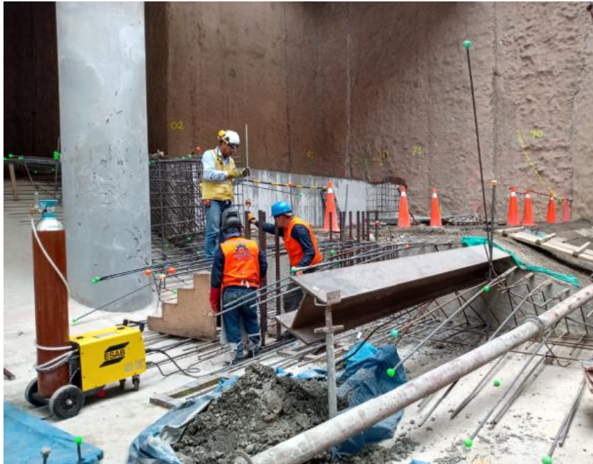
Colocación de riel para TBM
