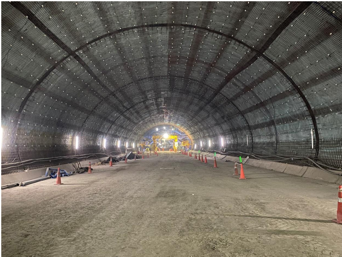
Impermeabilización y armadura boveda.
