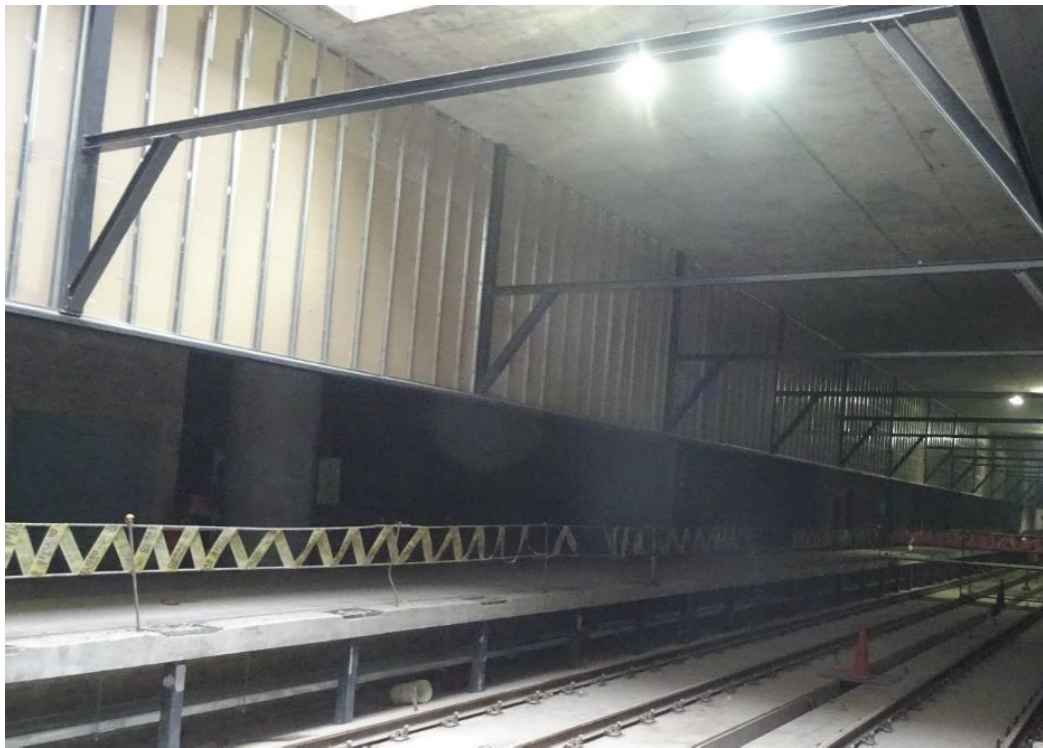
Cubierta sobre puertas de andén
