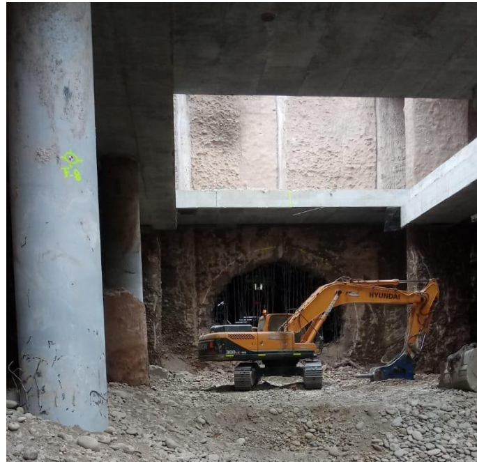
Calado del túnel NATM (lado Ate)
