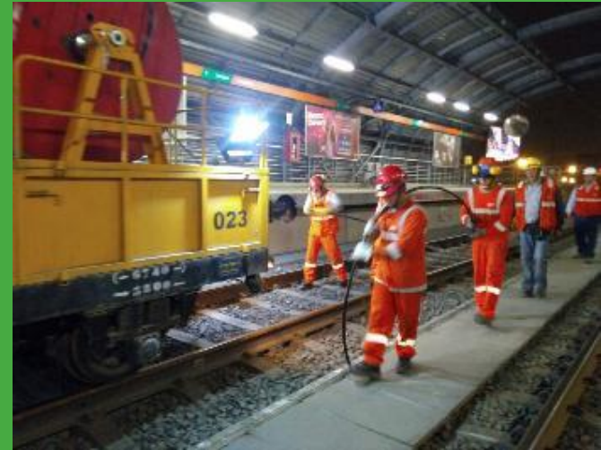
Obra 2: Tendido Cable MT
