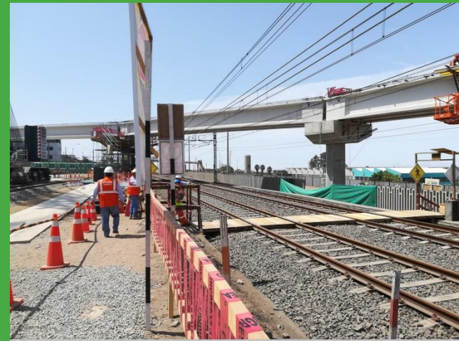
Obra 3: Vigas nuevo viaducto
