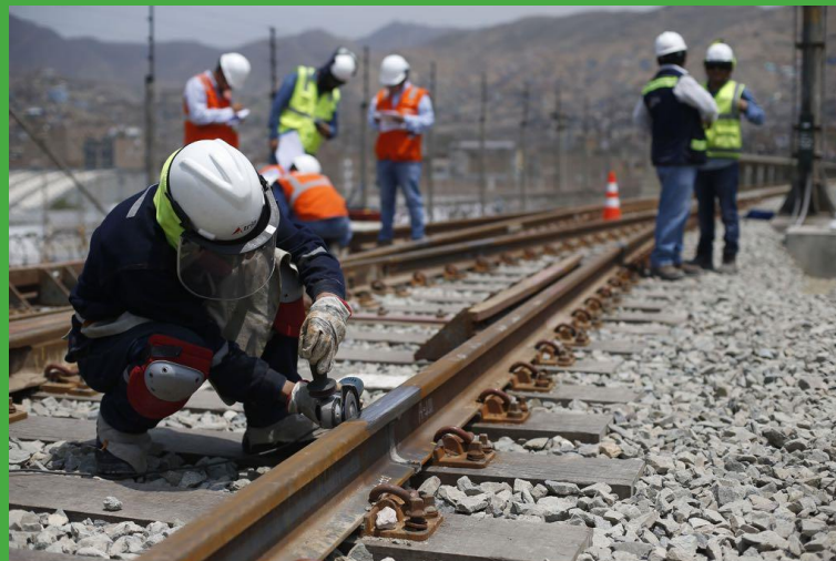
Obra 4: terminación de soldaduras
