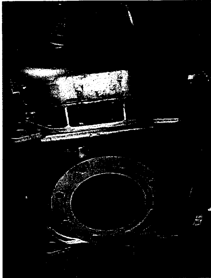
Boca de vacío en plataforma
