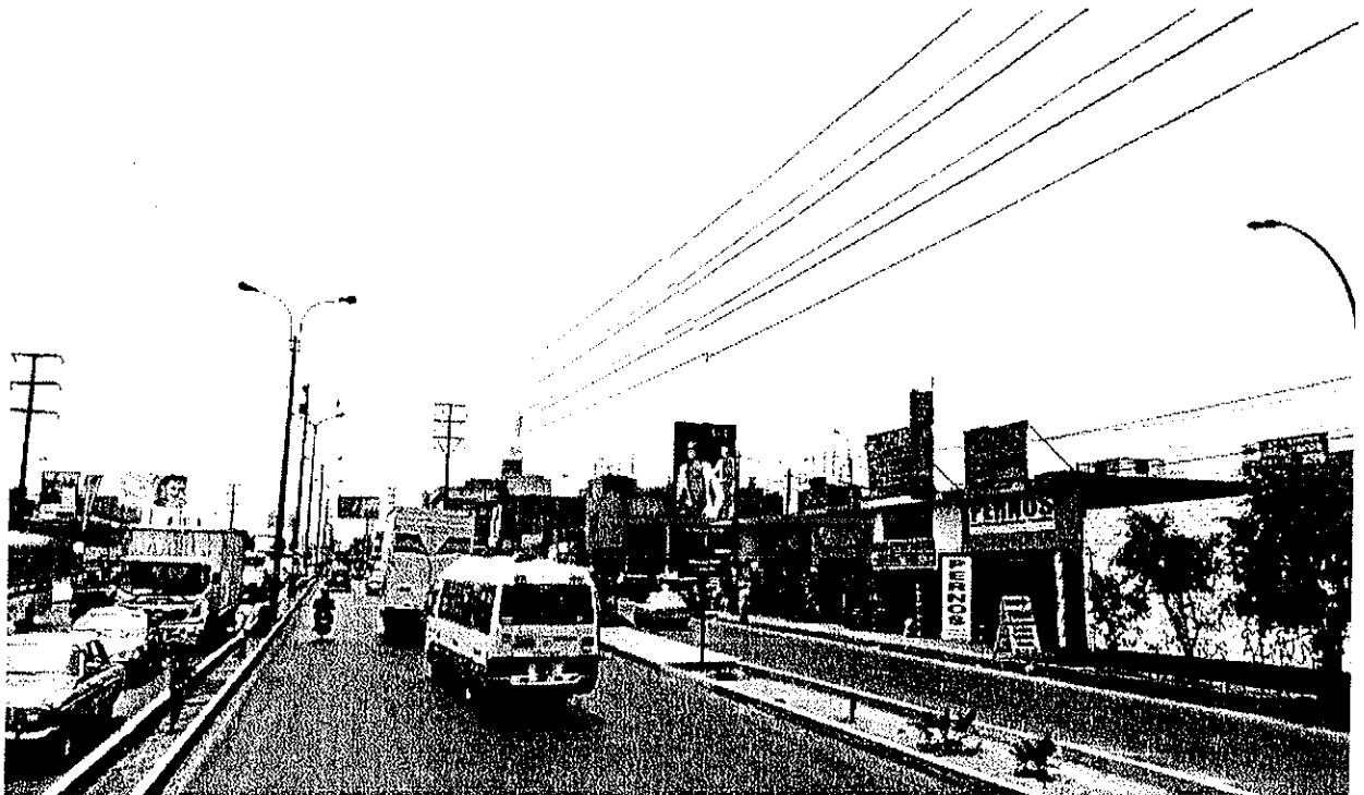
Imagen 5. Fotografía de la Carretera Central, vista en sentido Ate. Se observa la zona que se ocupará para la construcción del pozo de ventilación 21. La zona de la derecha de la fotografía será ocupada para ejecutar los accesos y ventilación del pozo.
