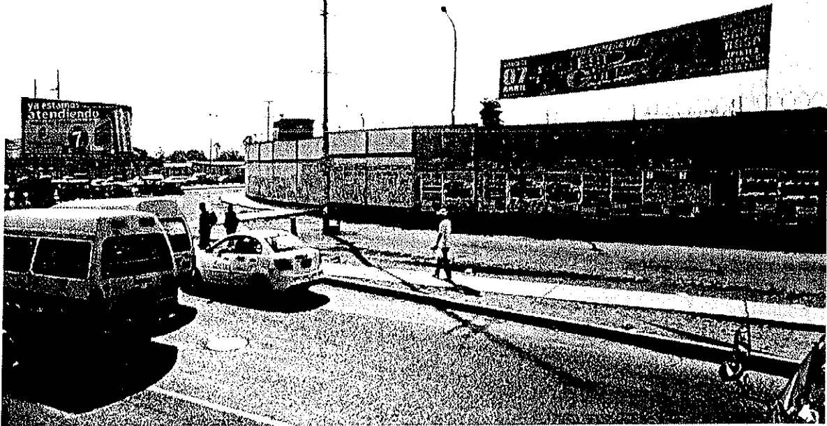
Imagen 9. Fotografía de la Carretera Central, vista en sentido Lima. Se observa la zona que se ocupará para la construcción del pozo de ventilación 23. Entre el cerramiento que se aprecia al fondo y la calzada se ejecutarán los accesos y ventilación del pozo.
