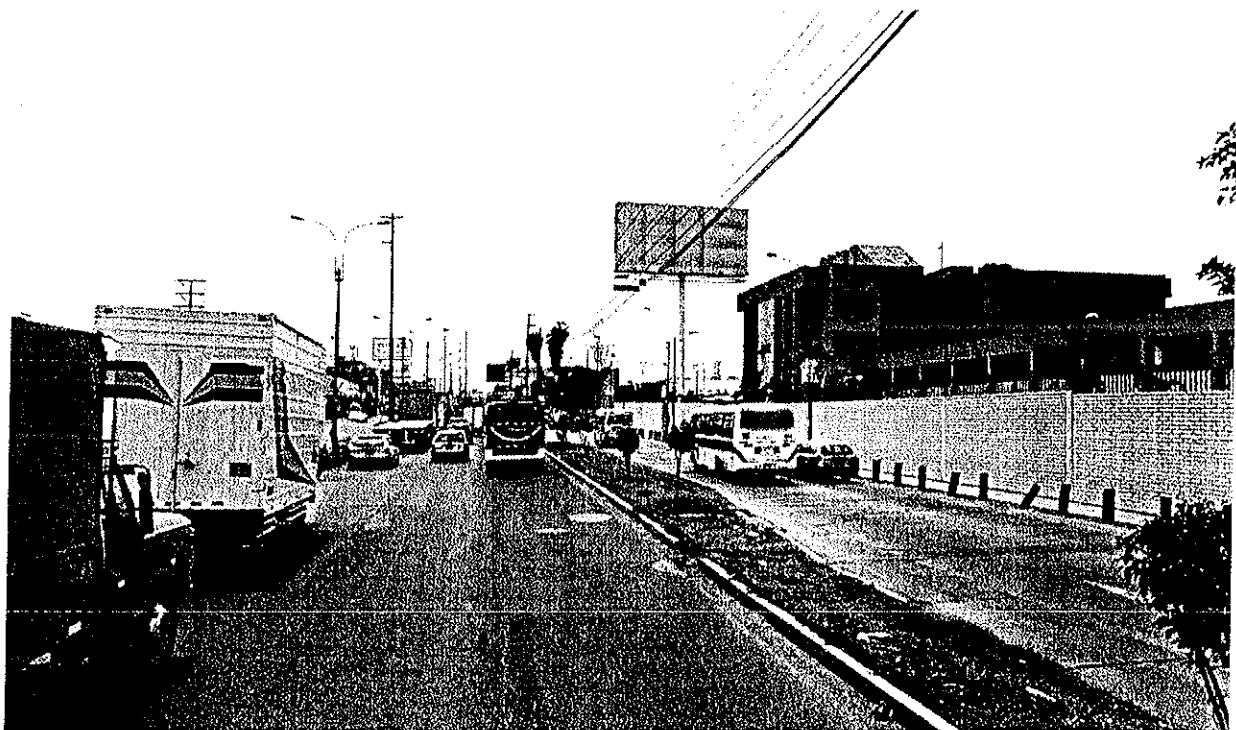
Imagen 4. Fotografía de la Carretera Central, vista en sentido Ate. Se observa la zona que se ocupará para la construcción de la estación Óvalo Santa Anita. El vial de la derecha de la fotografía se utilizará para dar continuidad a la circulación por la vía en sentido Ate, mientras la zona central está afectada por el cerramiento de la obra.
