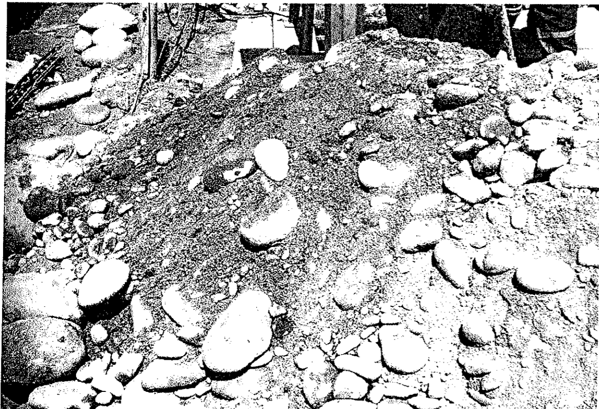
Acopio gravas de 7,7 a 10 m.
