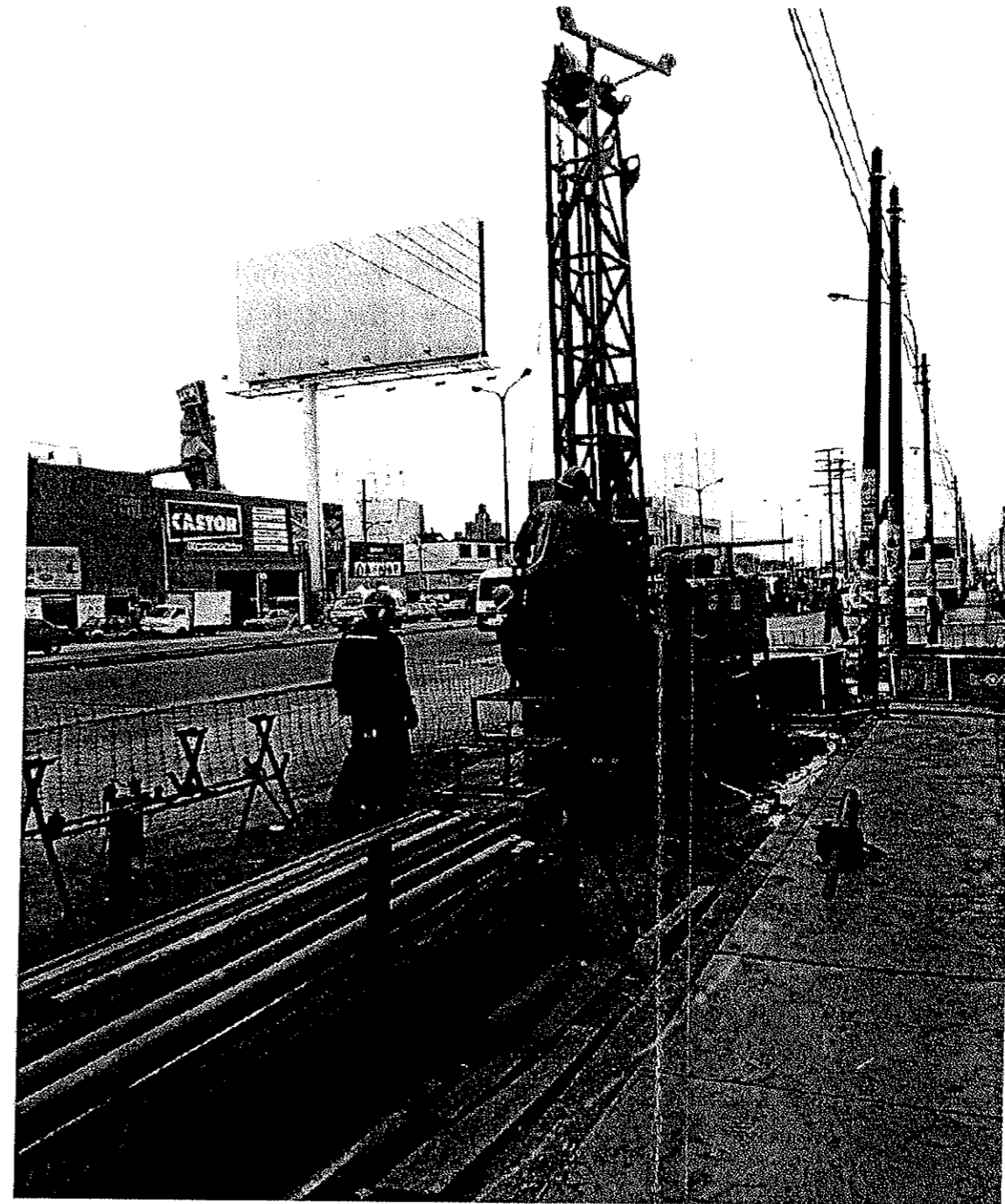
Vista del sondeo durante la perforación
