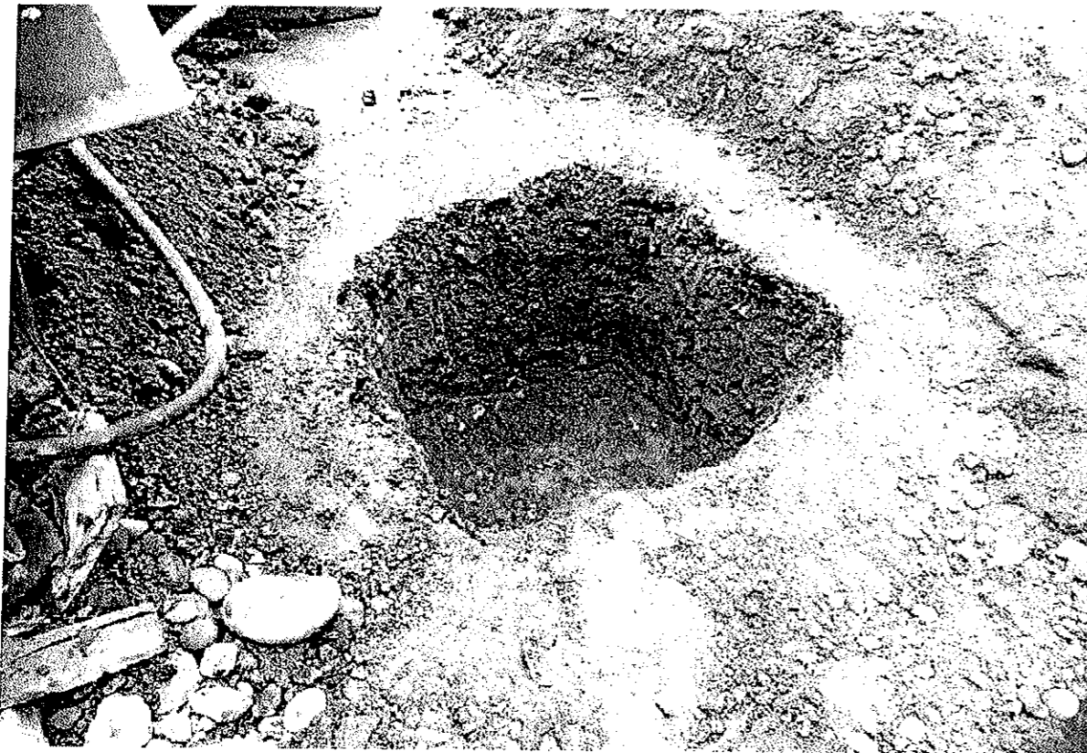
Cata realizada para comprobación de servicios
