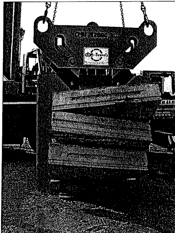
Descarga mediante grúa móvil
