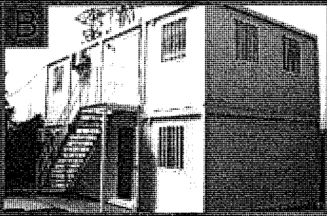
OFICINAS DE OBRA
