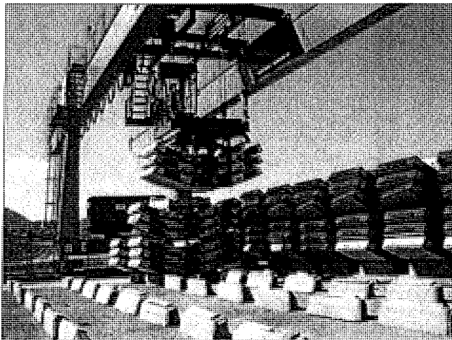
Grúa pórtico. Acopio de dovelas
