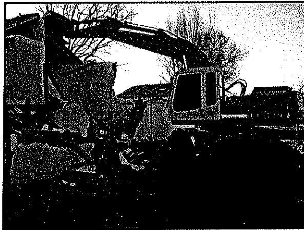
Demolición de Edificaciones
