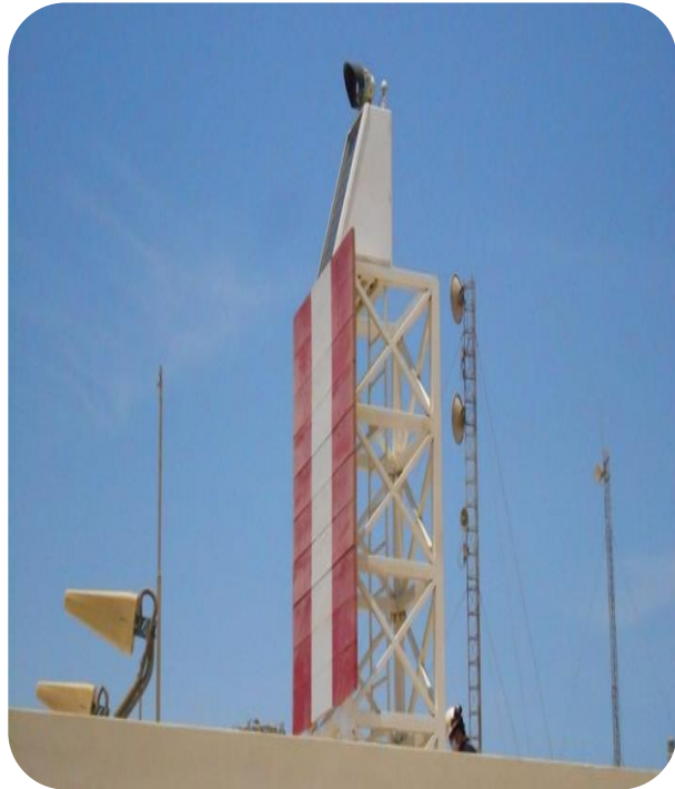
TORRE DE ENFILACIÓN
