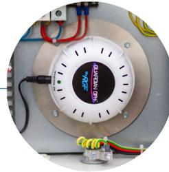
Instalación de purificadores de aire en los Rooftops.
