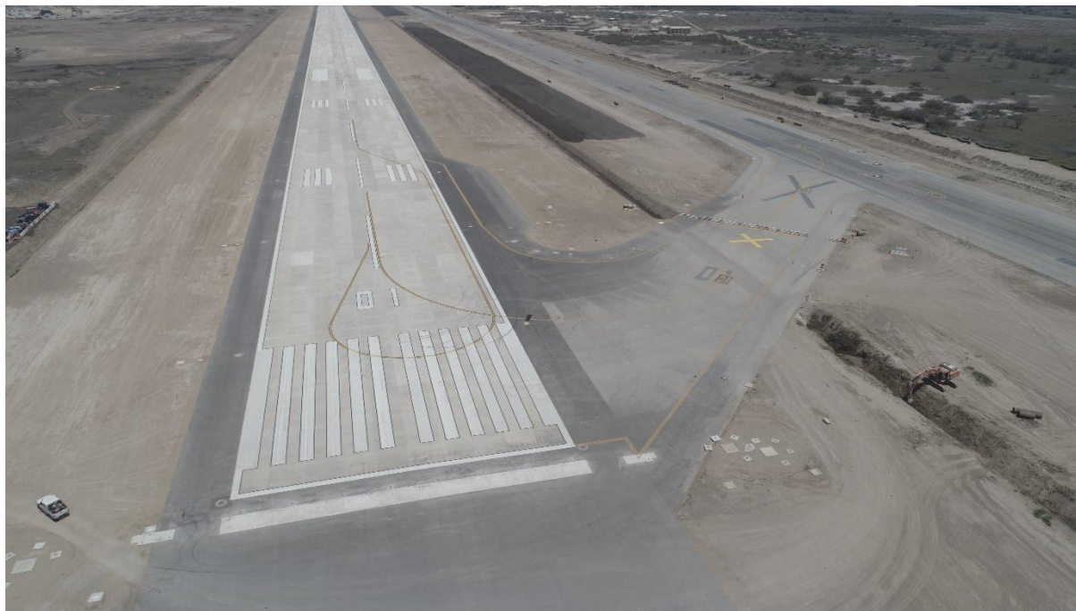
Vista desde la Cabecera 01 de la Pista de Aterrizaje
