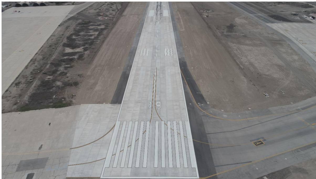
Vista desde la Cabecera 19 de la Pista de Aterrizaje
