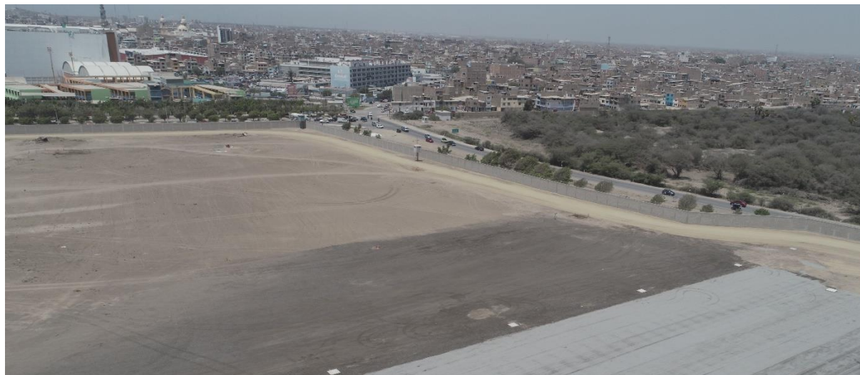
Cerco y Vía Perimetral Culminadas
