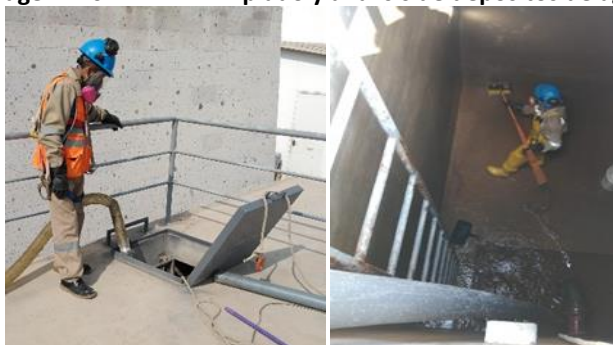
Imagen N°07: PMP - Limpiado y análisis de depósitos de agua
