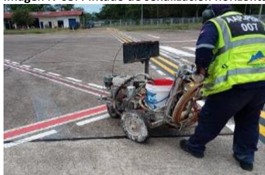
Imagen N°03: Pintado de señalización horizontal
