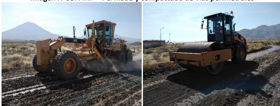
Imagen N°08: PMP – Perfilado y compactado de vías perimetrales
