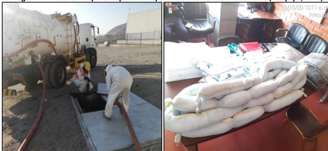
Imagen N°37: Succión de pozos sépticos e inspección de contenido antiderrame (Arequipa, 2020)
