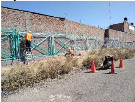
Imagen N°09: PMP – Pintado de Cerco Perimétrico
