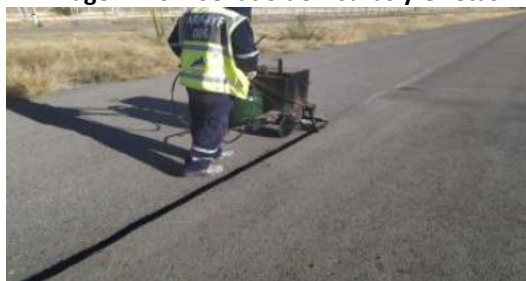
Imagen N°02: Sellado de Fisuras y Grietas
