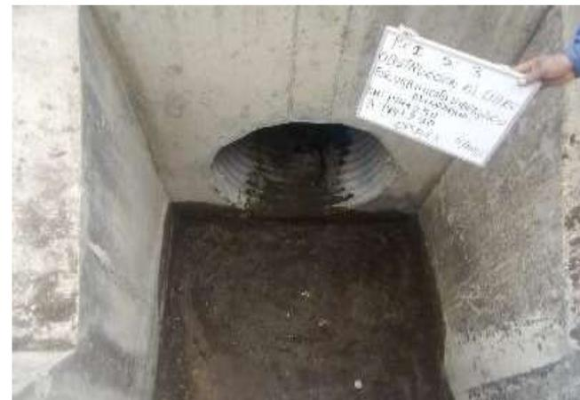
Obstrucción al libre escurrimiento del Caudal de diseño hidráulico en alcantarillas - Después
