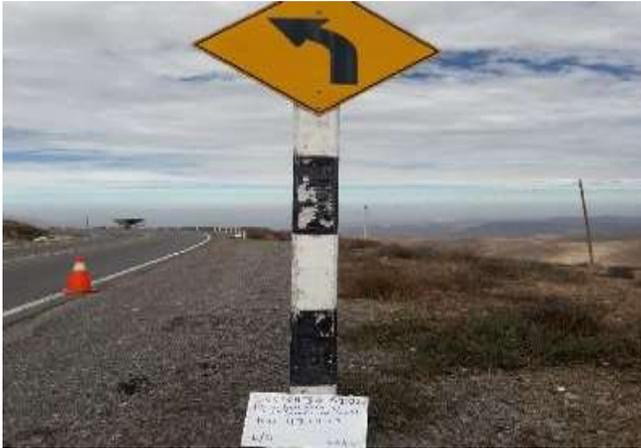
Deterioro de los soportes de las señales
