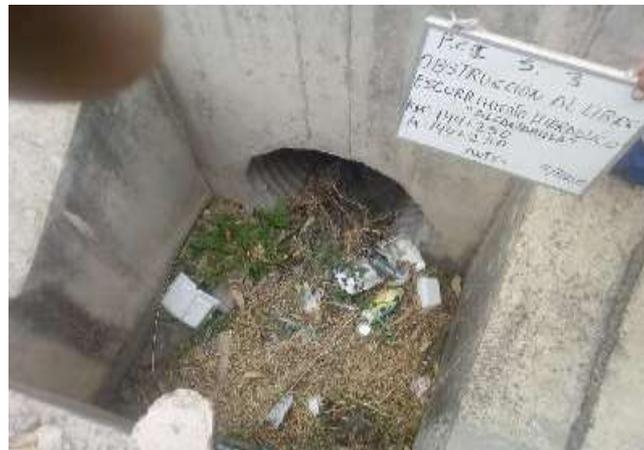
Obstrucción al libre escurrimiento del Caudal de diseño hidráulico en alcantarillas- Antes
