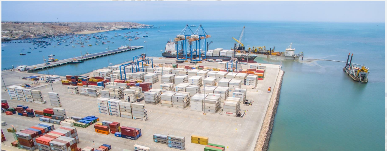
Draga Marco Polo y Charles Darwin realizando trabajos de Dragado en el Terminal
