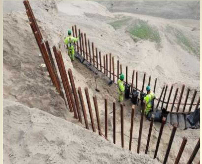
En el tramo Serpentin de Pasamayo existen zonas en las cuales los taludes inferiores se erosionan por la acción del viento, por ello, con el fin de evitar la erosión del talud inferior Norvial, utiliza un sistema andenerías para protegerlos.
