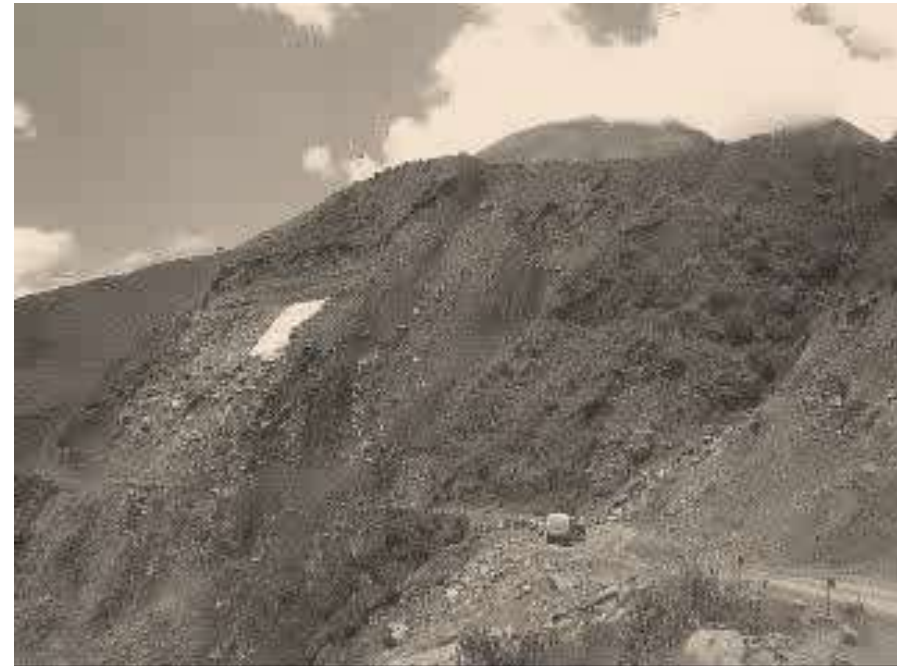
Túnel Wayrasencca (antes)
