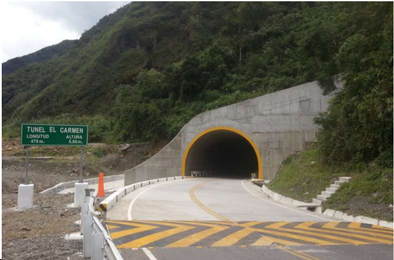
Portal de Entrada Túnel El Carmen - Km. 262
