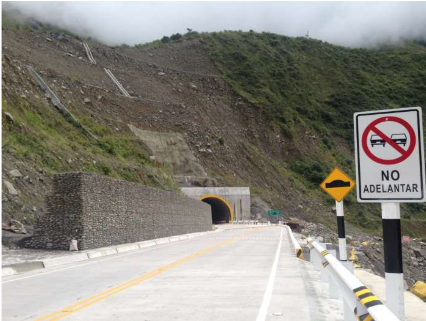
Portal de Entrada Túnel Wayrasencca- Km. 237
