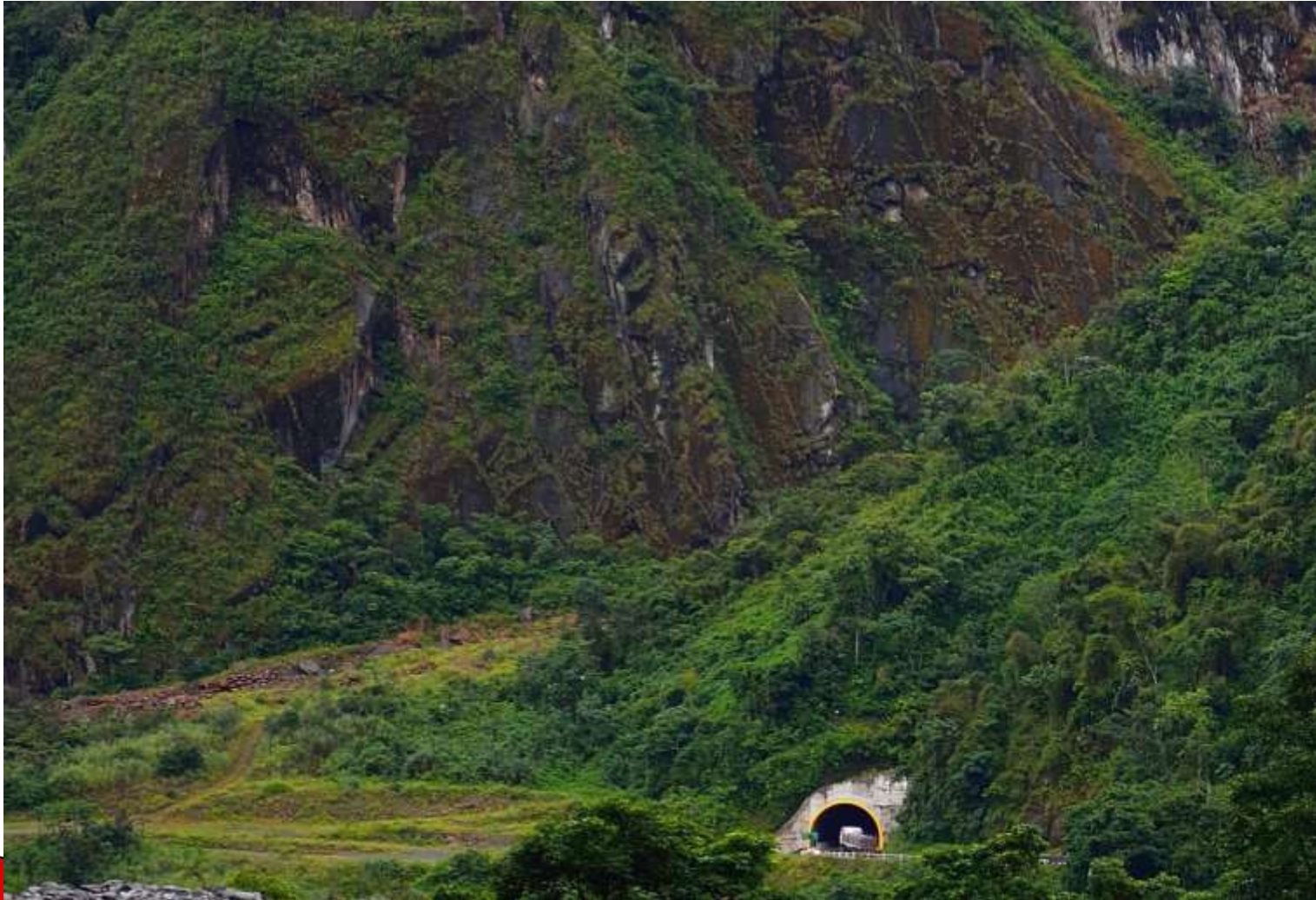
Túnel El Carmen
