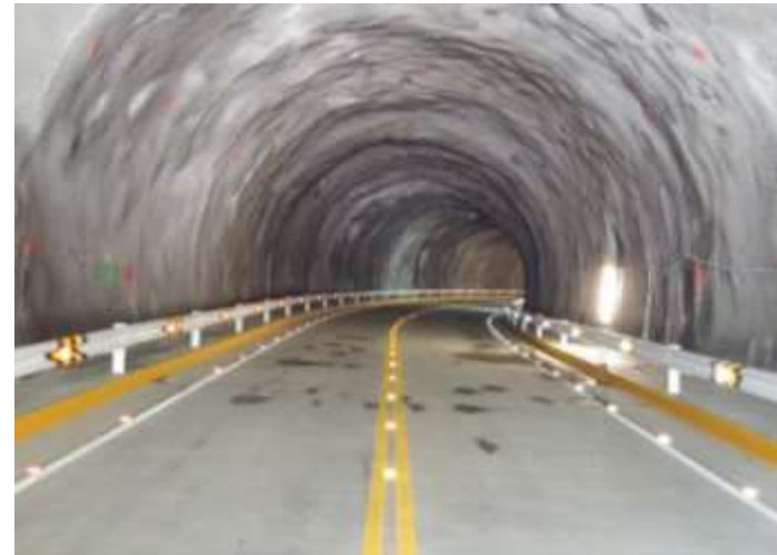
Túnel Wayrasencca (ahora)
