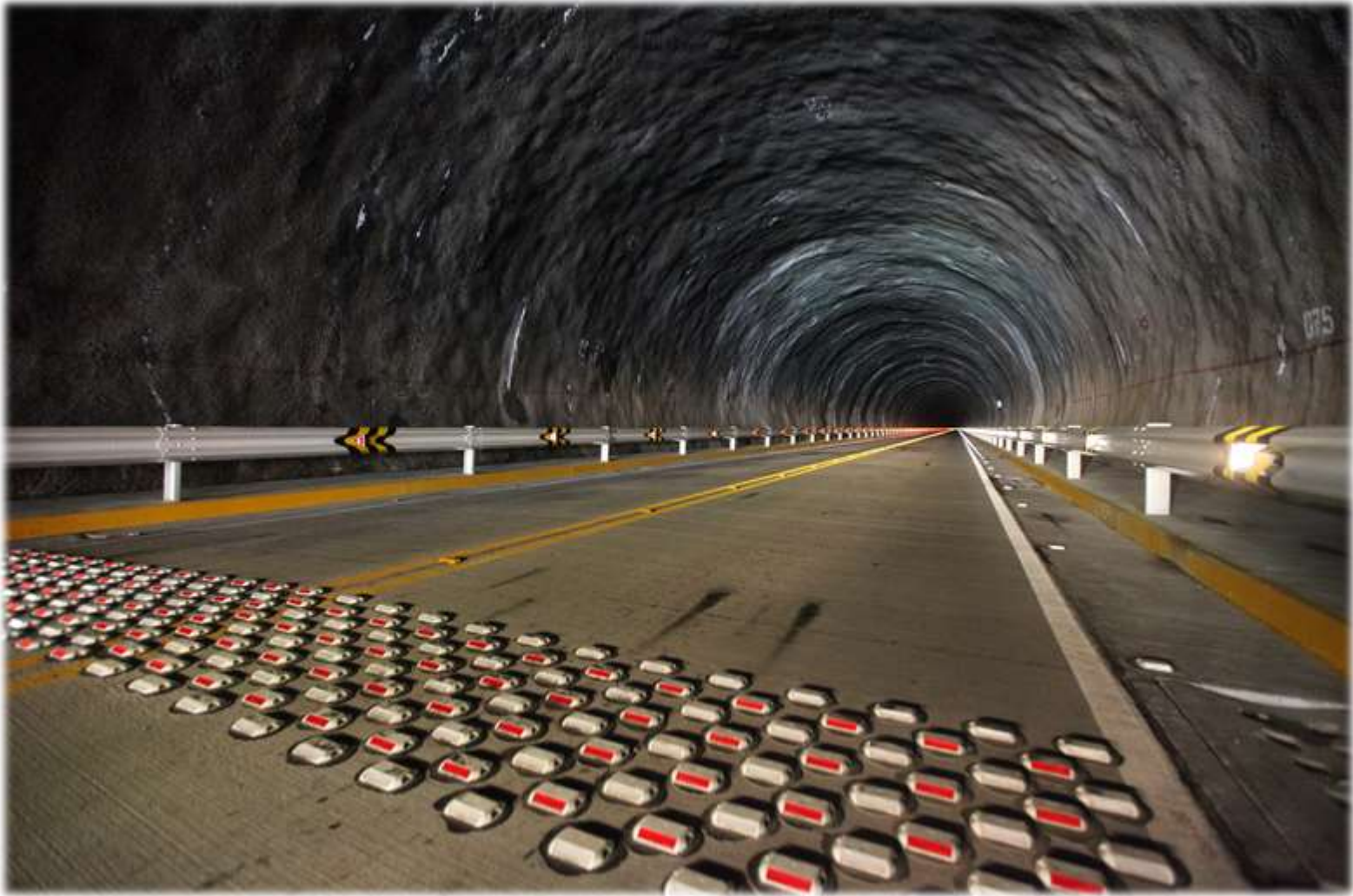
Túnel Sococtaca - Km. 222
