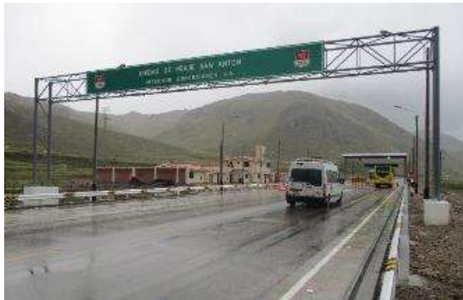
UNIDAD DE PEAJE SAN ANTON KM 107 + 300
