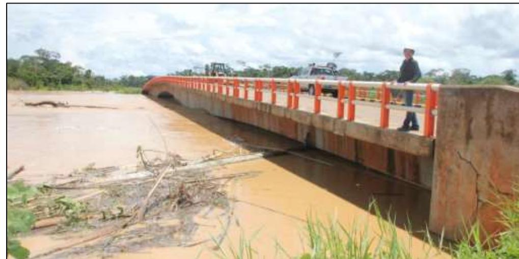
Durante el periodo de lluvias del año 2012 se registró una máxima avenida del rio con presencia de palizada, llegando a la cota de 249.88 msnm superando el nivel de la avenida máxima de diseño del puente actual en 2.00m (249.88 - 247.88).
