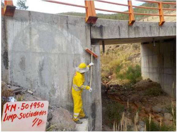
Limpieza de superficie de concreto y dispositivos de drenaje
