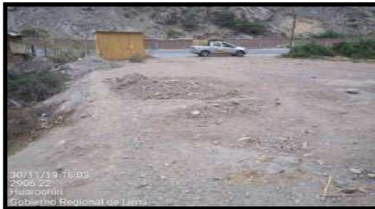
DME – Km. 047+100 SUB TRAMO 1
